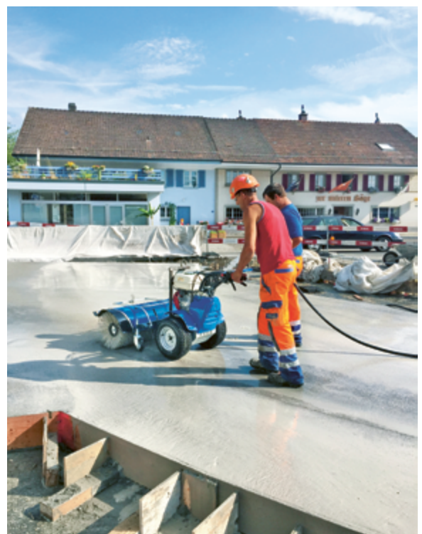
Maschinelles Ausbürsten der Zementhaut zum Erstellen der Waschbetonoberfläche
