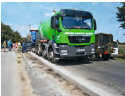
K9 Meerbusch (NRW) Vorbereitete Unterlage für Bankettbeton mit Einbauequipment
