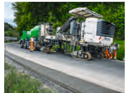
B460 Hüttenthal-Marbach (HE) Einbau zweiter Bankettbetonstreifen mit Offset-Gleitschalungsfertiger
