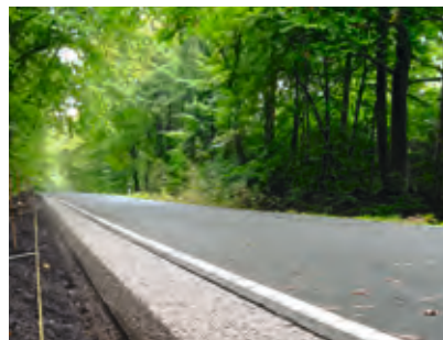
L208 Aumühle-Kuddewörde (SH) Am Leitdraht hergestellter Bankettbetonstreifen
