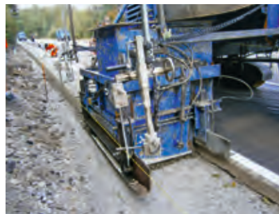
K1057 Panzerstraße Böblingen (BW) Betoneinbaumulde, Einbau Leitpfosten, Nachbehandlung
