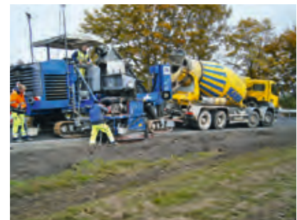
BAB A61 AS Mendig (RP) Bankettbetoneinbau mit Offset- Gleitschalungsfertiger
