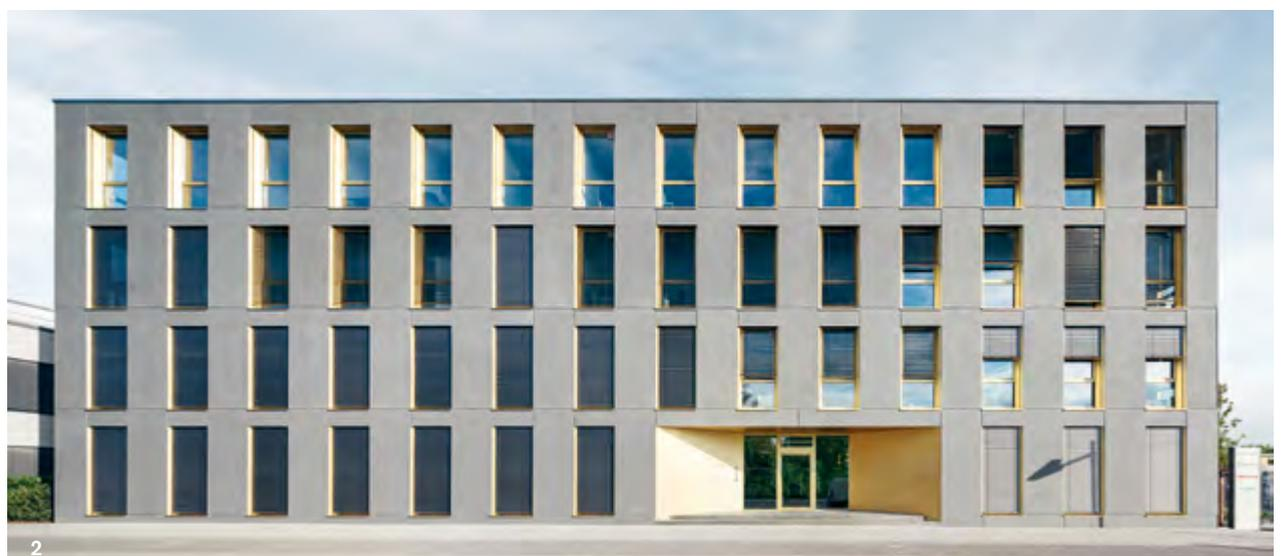
noch nicht so weit waren. Getragen wurde das energetische Gesamtkonzept durch die massive Bauweise und die hochgedämmten, passiv aktivierten Fertigteilfassaden.
