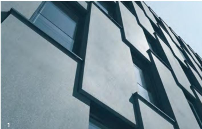
**1** Das Bürohaus Eastsite One in Mannheim-Neustheim ist geprägt von einer plastischen Schuppenfassade, die auf einem sich wiederholenden Bauteil beruht – ein Novum in der Betonsandwichbautechnik. Die Schuppen entstehen durch Schrägstellung der Bauteile um 7°. **2** Das Eastsite VIII mit Sandwechenelementen aus Textilbeton. Durch den Einsatz von Textil lässt sich der Materialeinsatz um 70 Prozent reduzieren.
