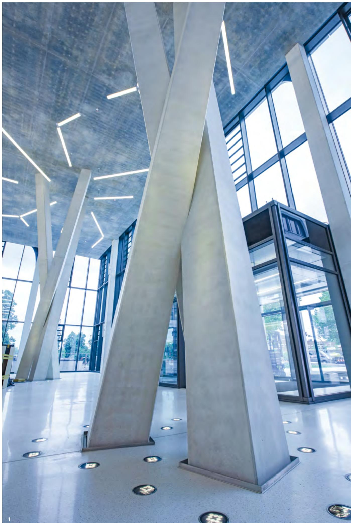
1 Die Haupteinschließung der Hauptverwaltung der Heidelberg Materials AG erfolgt über das repräsentative Foyer, das drei Geschosse hoch ist und im Inneren viel Sichtbeton zeigt. Eingesetzt wurde ein selbstverdichtender Feinbeton der höchsten Sichtbeton-Klasse SB 4 für die zum Teil filigranen und dicht bewehrten Bauteile, wie Stützen, Wände und die drei im Raum stehenden spektakulären Baumstützen.
