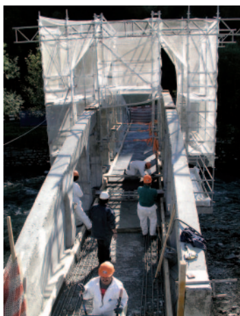
Einbau der multifunktionalen UHFB-Schicht (Verstärkung, Abdichtung, Fahrbahnbelag)
