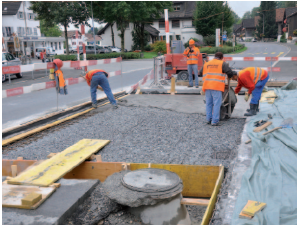
Einbau der Abdichtungsschicht aus UHFB
