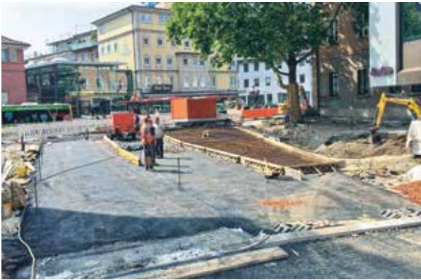
Abb. 2: Unterbau (Asphalttragschicht)
