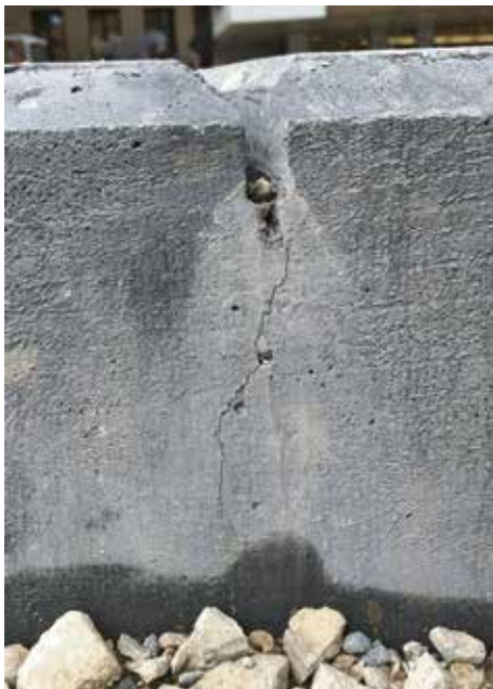
Abb. 5: Scheinfuge mit Voute und geplantem Riss
