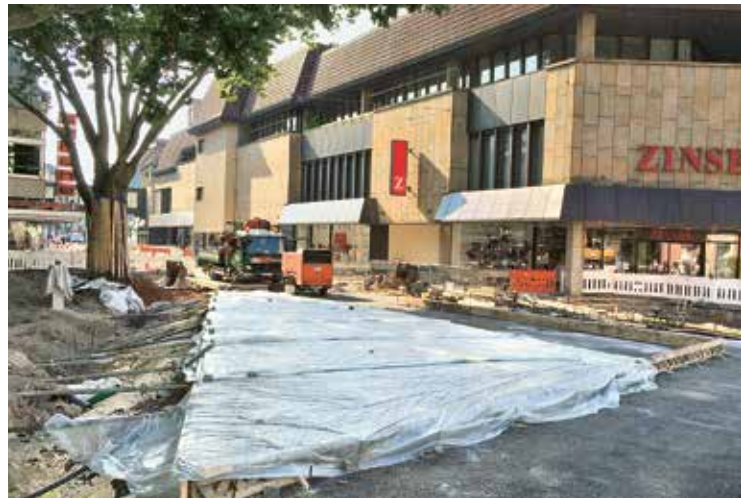
Abb. 10: Einpacken der Betonflächen mit Folie (Nachbehandlung)
