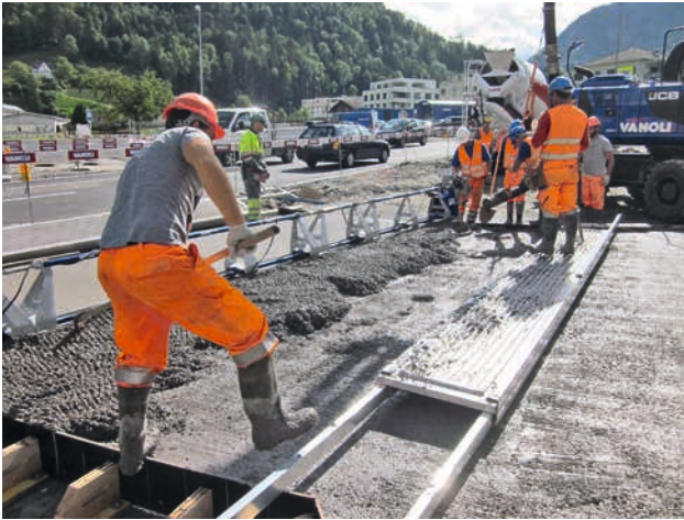
3. Einbringen des Oberbetons, d = 6\text{ cm}
