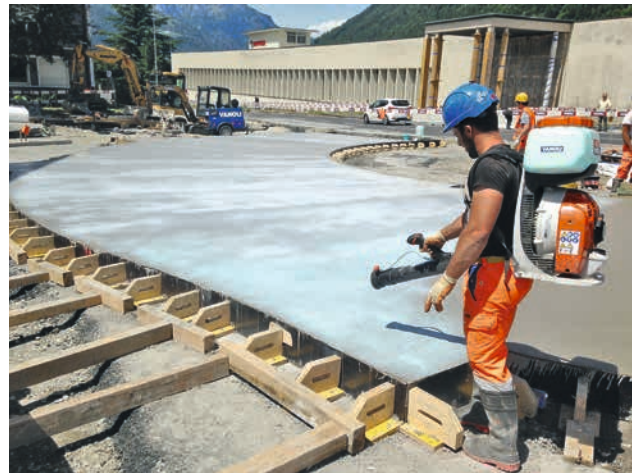
5. Aufsprühen eines Kombimittels (Verzögerer und Curing)
