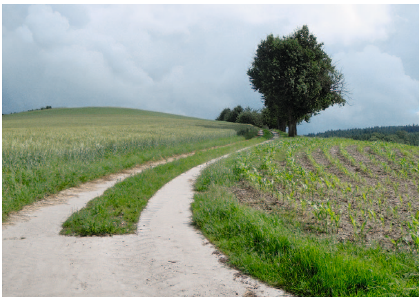
Abbildung 5: Fertiger, begrünter Betonspurweg «Dallinger», Oberösterreich (Foto VÖZ)
