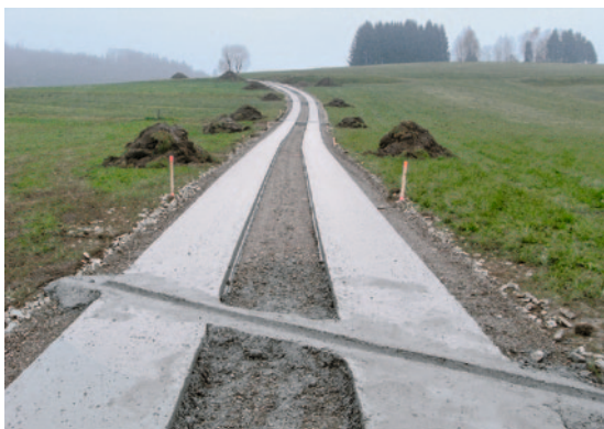
Abbildung 4: Querentwässerungsrinne (Foto Haslehner, Amt der Burgenländischen Landesregierung)
