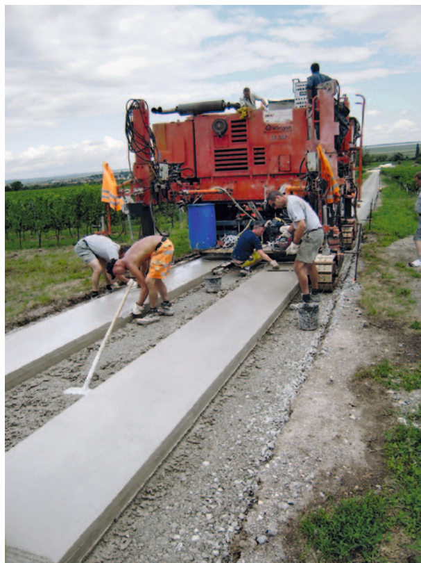
Abbildung 1: Einbau mit Fertiger, Betonspurweg Rust/Oggau - Burgenland 2011 (Foto VÖZ)
