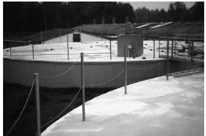
Bild 3: Biogasfermenter mit Betondecke
