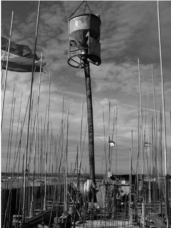
Bild 5: Betoneinbau mit Schlauchkübel
