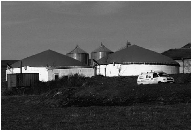
Bild 2: Biogasfermenter mit Foliendach
