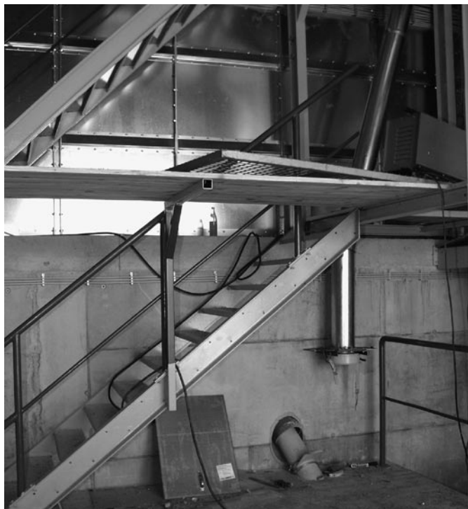
Bild 3: Getreidelager (Viereckzellen) mit betonierten Trichterausläufen in der Bauphase
