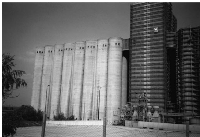
Bild 4: Außensiloanlage eines Getreidegroßlagers (Foto: T. Richter, Berlin)
