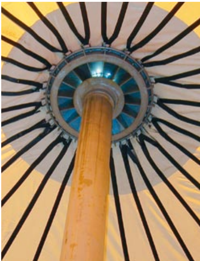
Bild 2: Innenansicht eines Güllebehälters mit Zeltdach
