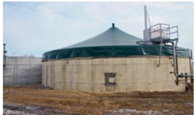
Bild 3: Außenansicht eines Güllebehälters mit Zeltdach
