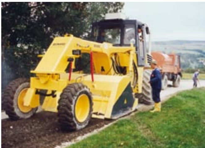
Bild 23: Einfräsen von Zement beim Fräsrecycling
