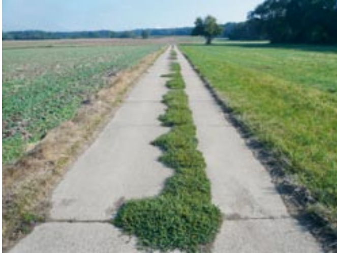
Bild 6: Längsriß mit Pflanzenbewuchs
