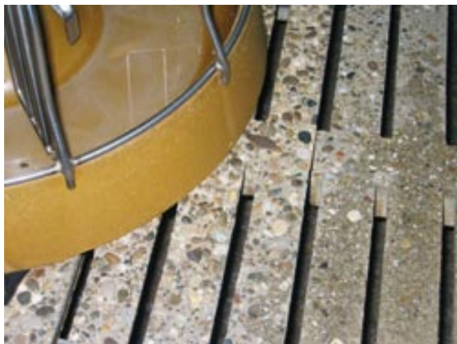
Bild 3: Chemischer Angriff bei Schweine-Fressplätzen
