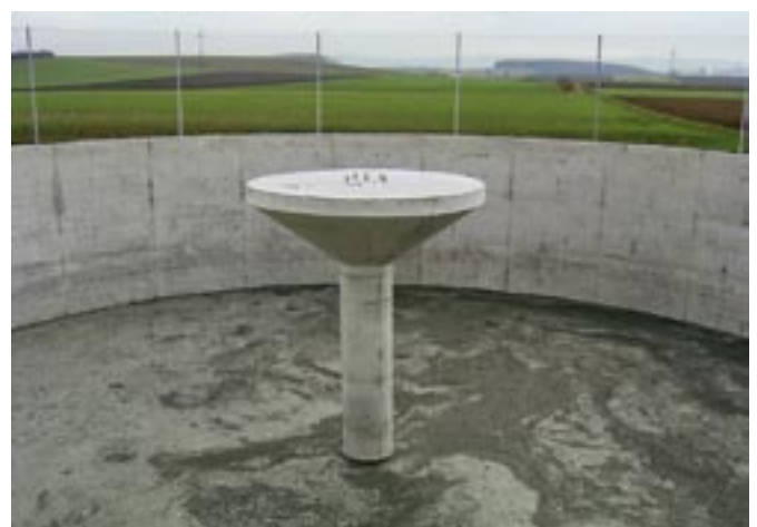
Bild 4: Vorsorglich errichtete Mittelstütze für eine eventuell notwendige Abdeckung
