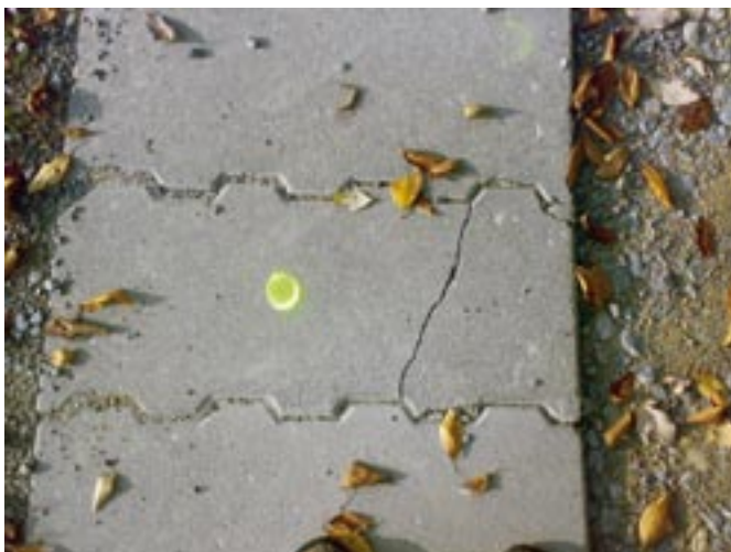
Bild 21: Plattenbruch
