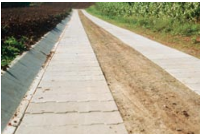
Bild 20: Verkantung von Spurplatten
