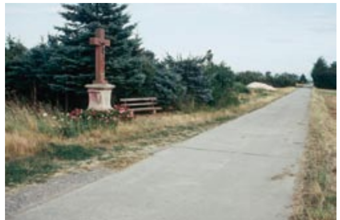
Bild 3: Betonweg aus den 50er Jahren des vergangenen Jahrhunderts
