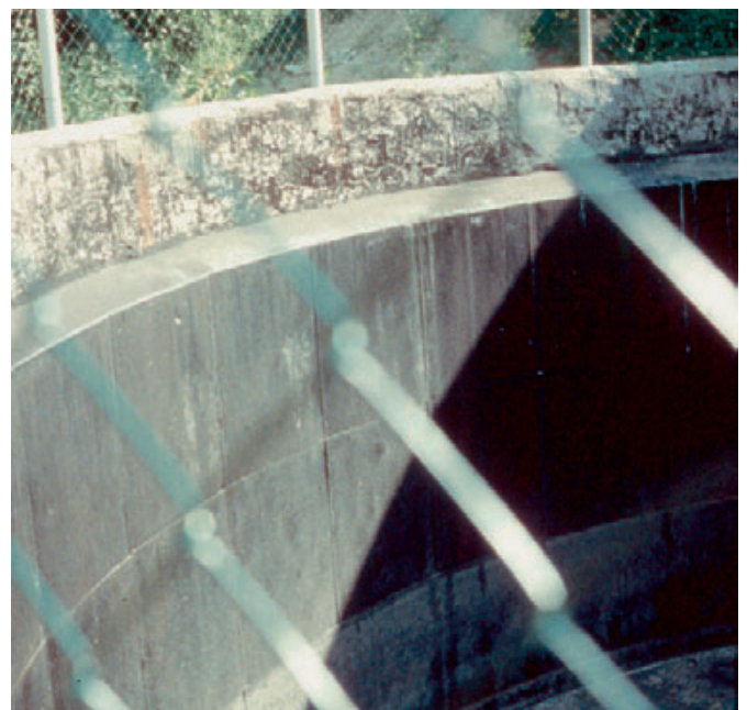
Bild 7: Instandsetzung eines Güllebehälters durch eine neue Betoninnenschale
