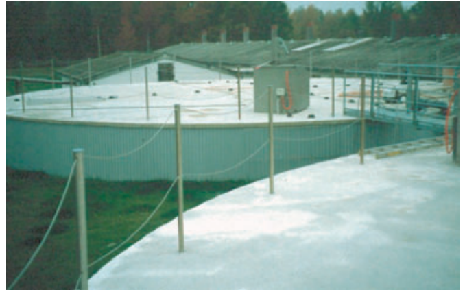
Bild 3: Biogasfermenter mit Betondecke
