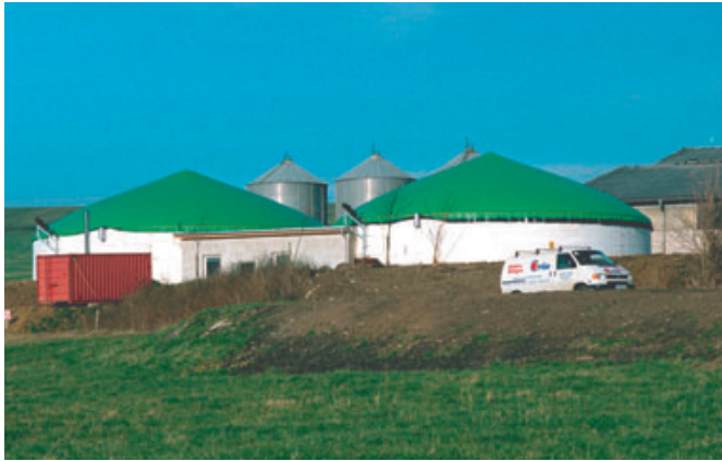
Bild 2: Biogasfermenter mit Foliendach
