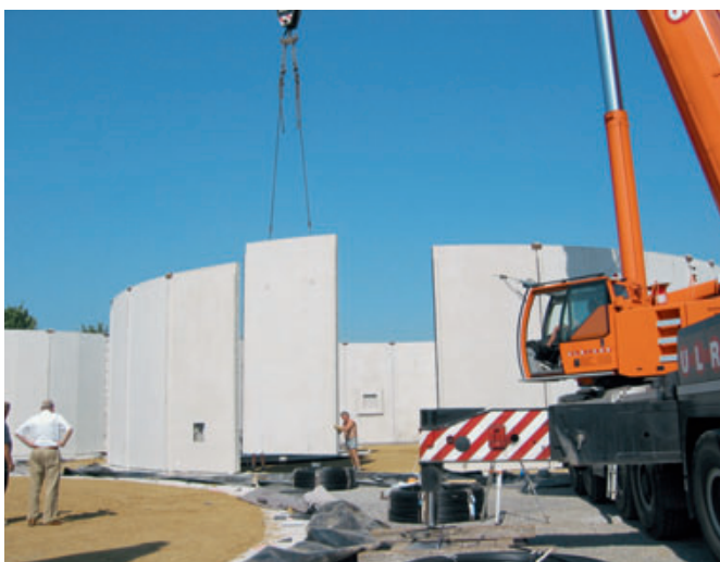
Bild 1: Wandmontage eines Spannbeton-Fertigteilbehälters
