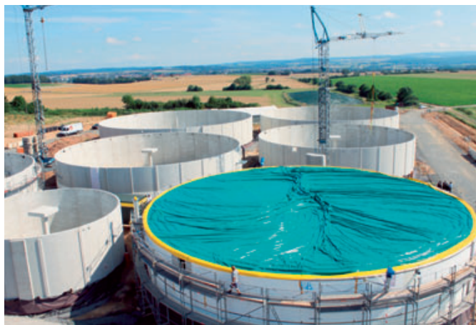
Bild 5: Montage eines Membrandachs
