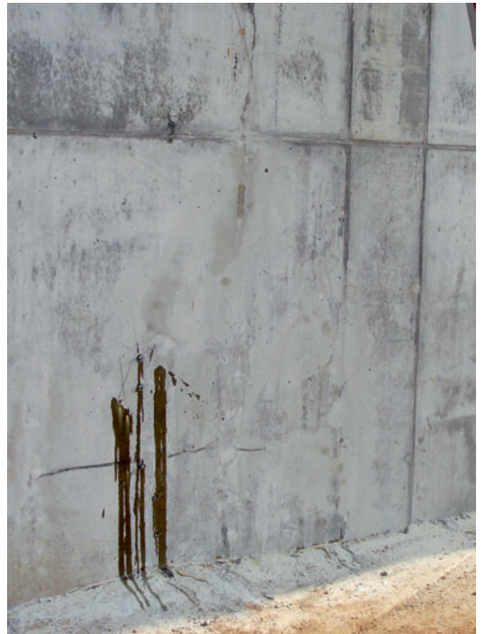
Bild 11: Kraftschlüssige Rissverpressung an einem Güllebehälter
