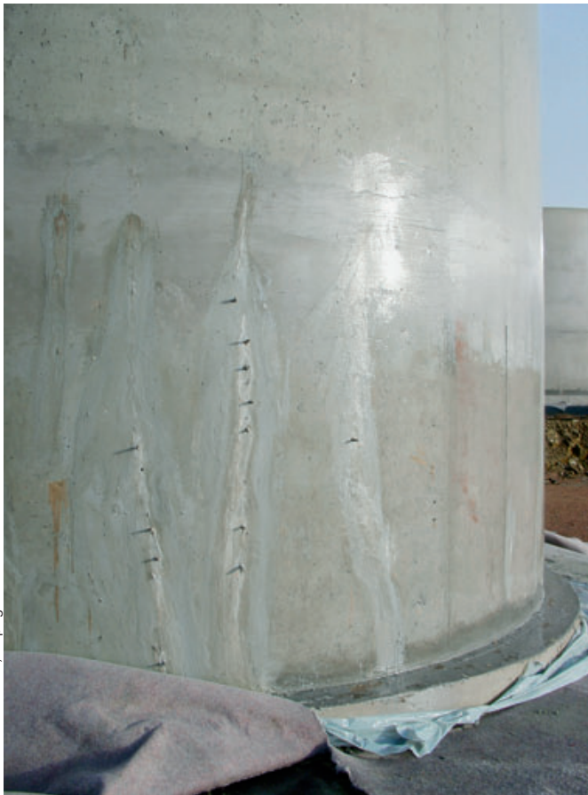
Bild 10: Dehnfähige Rissverpressung zur Rissabdichtung an einem Güllebehälter
