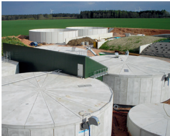
Bild 4: Biogasanlage mit Fermentern und Nachgärbehältern in Sandwichbauweise mit Stahlbetondecke
