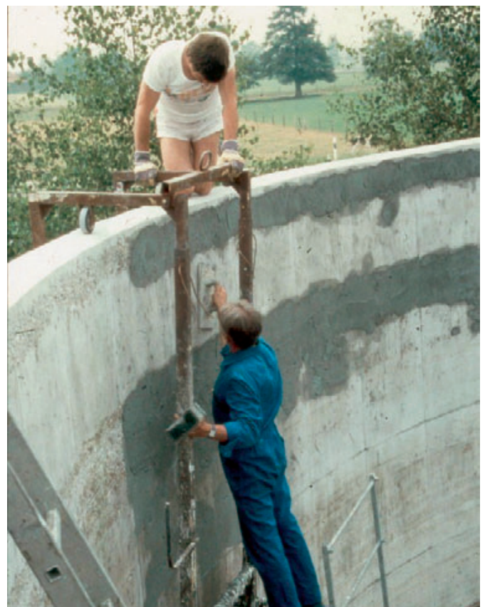
Bild 5: Auftragen eines kunststoffmodifizierten Zementmörtels bei der Instandsetzung von Betonabplatzungen
