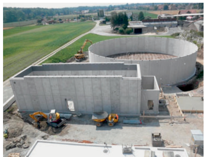
Bild 2: Pfropfenstromfermenter
