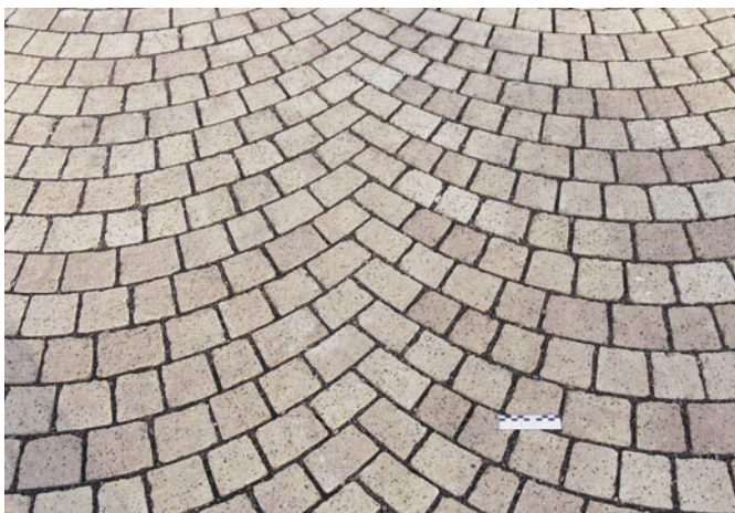
Bild 5: Von Naturstein kaum zu unterscheiden: Segmentbogenpflaster aus eingefärbtem und Oberflächen bearbeitetem Beton
