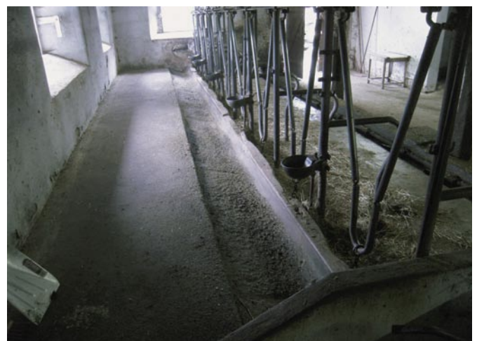
Bild 1: Futtertrog in einem Kuhstall nach 31 Jahren Nutzung
