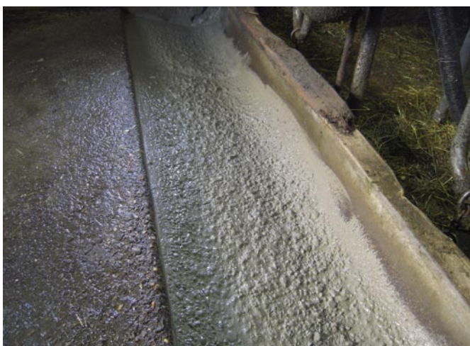
Bild 4: Auftrag der Haftschlämme mittels Bürste
