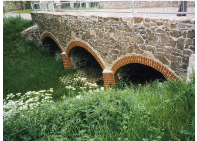
Bild 5: Instandgesetzte Brücke im ländlichen Wegebau
