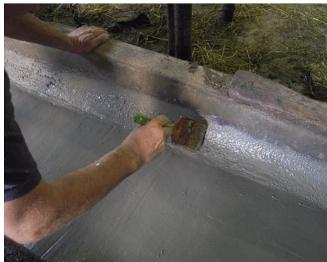
Bild 7: Besenstrich im Bereich der Rundung
