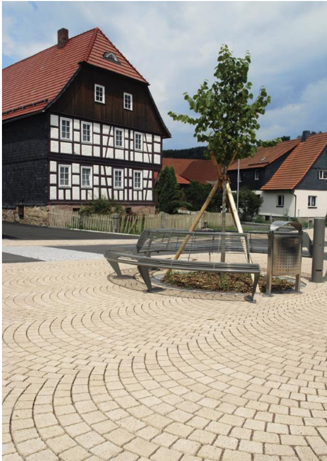
Bild 4: Das Segmentbogenpflaster bietet optisch und technisch eine ideale Befestigung für denkmalgeschützte Ortsbereiche.
