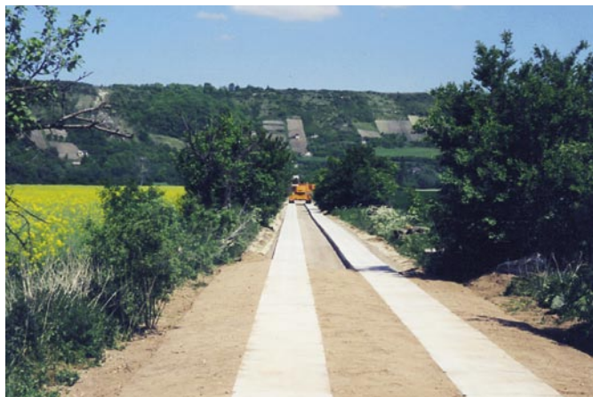
Bild 4: Betonplatten-Spurweg, System „Eichfeld“
