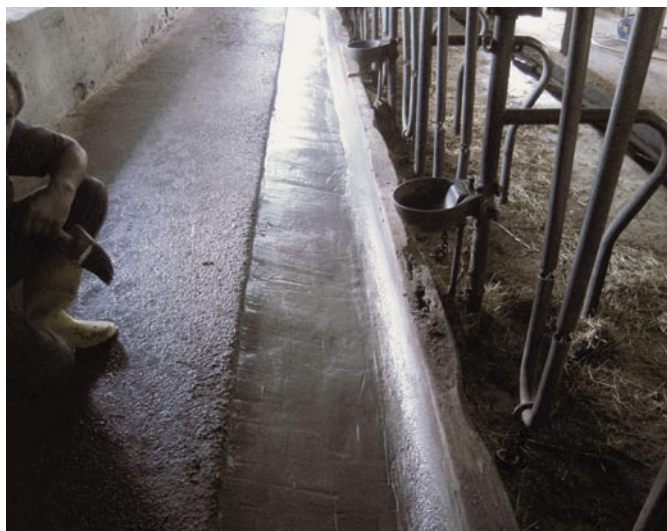
Bild 6: Geglättete Oberfläche
