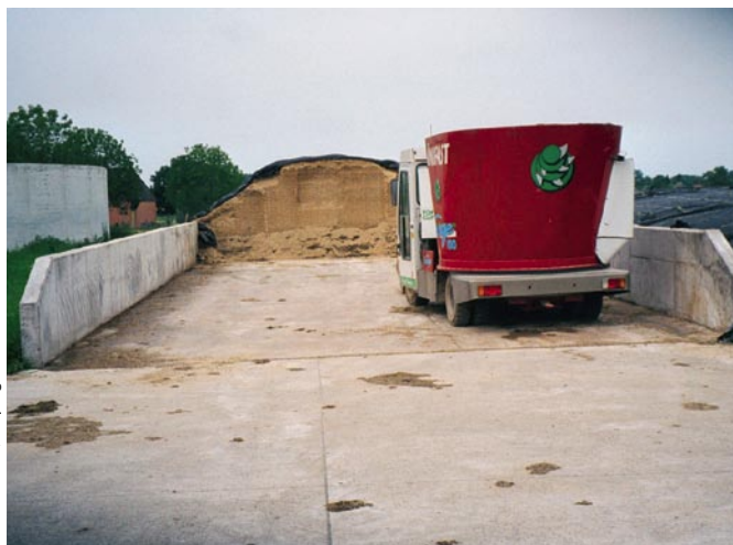
Bild 3: Siloplatte mit niedrigen Seitenwänden und Futterhaube
