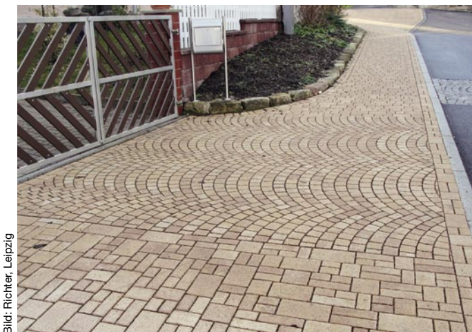
Bild 8: Segmentbogenpflasterung für die Hofeinfahrten
