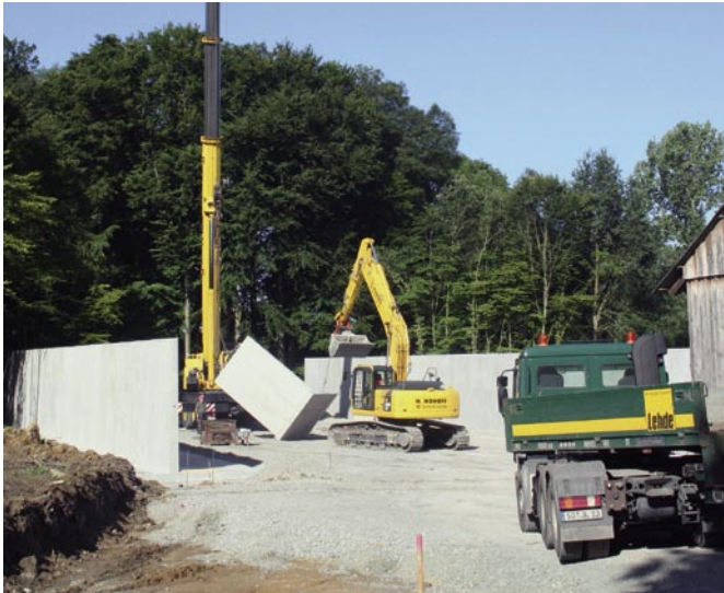
Bild 8: Silowände in Fertigteilbauweise mit abgedichteten Fugen
