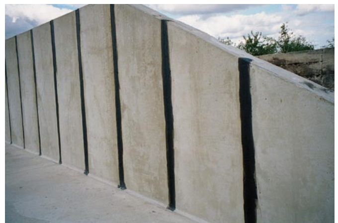
Bild 7: Ortbeton-Silowände mit abgedichteten Fugen
