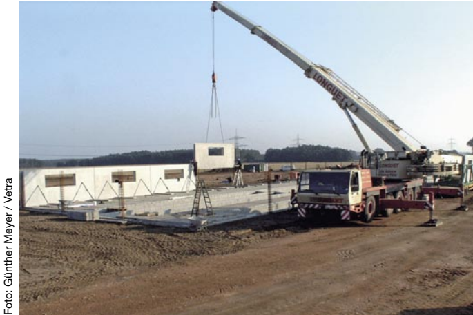
Bild 1: Mit Kränen werden die vorgefertigten Wände in die Aussteifungsstützen des Stallfundaments installiert. Diese modulare Bauweise erlaubt kurze Bauzeiten und eine sichere Montage.
