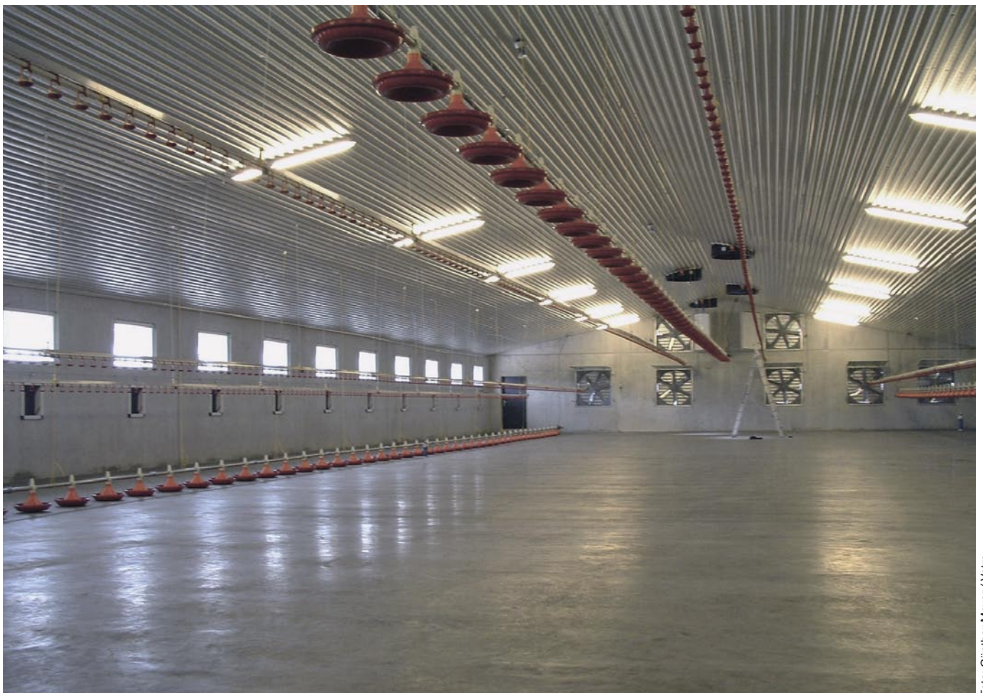
Bild 3: Auch nach der Endmontage innerhalb des Stalls bleiben die Agrarwände sichtbar. Belüftungsanlagen können direkt in die Wände integriert werden.
