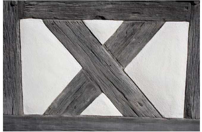
Bild 11: Detail verputzte Ausmauerung
