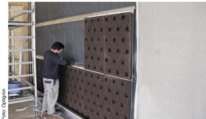
Bild 4: PE-Folie, Einhangschienen und erste Fassadenelemente sind angebracht.
