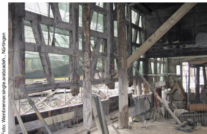
Bild 7: Instandsetzung der Fachwerkstruktur
