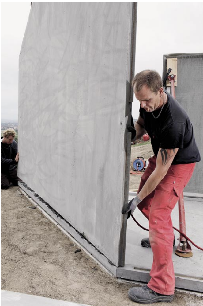
Bild 3: Wandmontage mit Verklebung der Fugen
