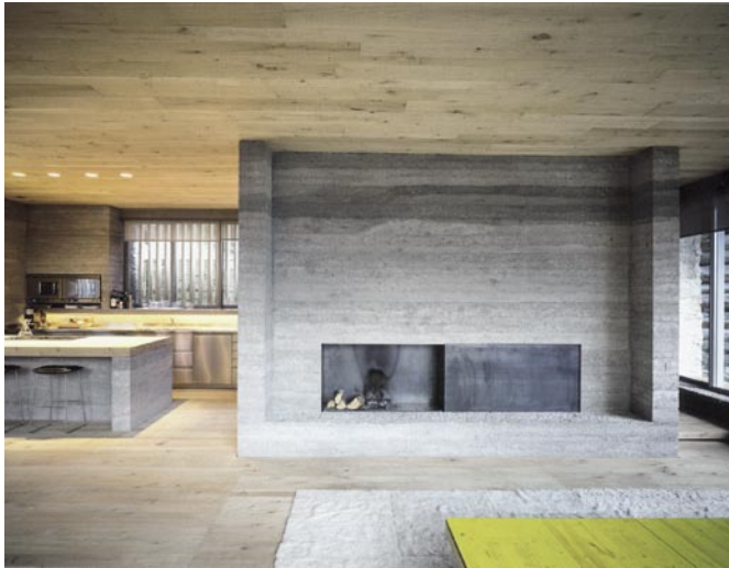
Bild 4: Stampfbetonkamin und Eichenholzdecke
