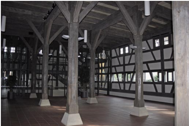
Bild 10: Ausgemauerte Fassade
