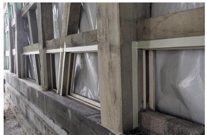
Bild 8: Abklebung des Fachwerks vor der Ausmauerung als temporärer Holzschutz vor Baufeuchte
