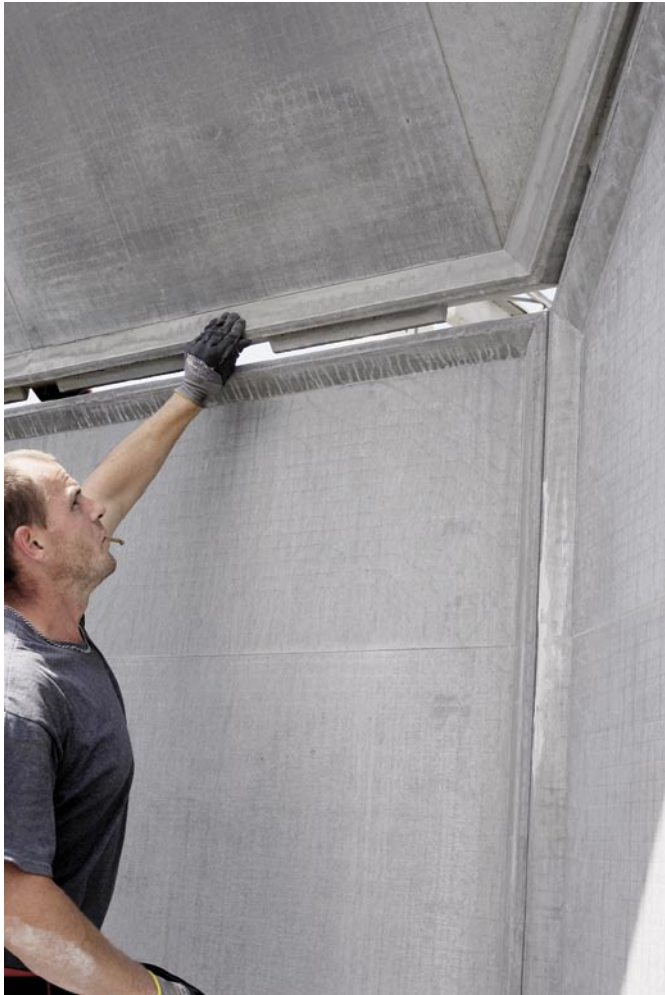
Bild 6: Fugendetail Dach-Wand-Anschluss
