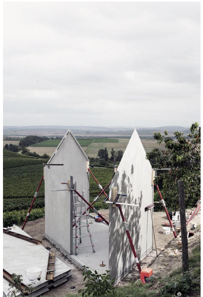
Bild 4: Weinberghaus während der Wandmontage
