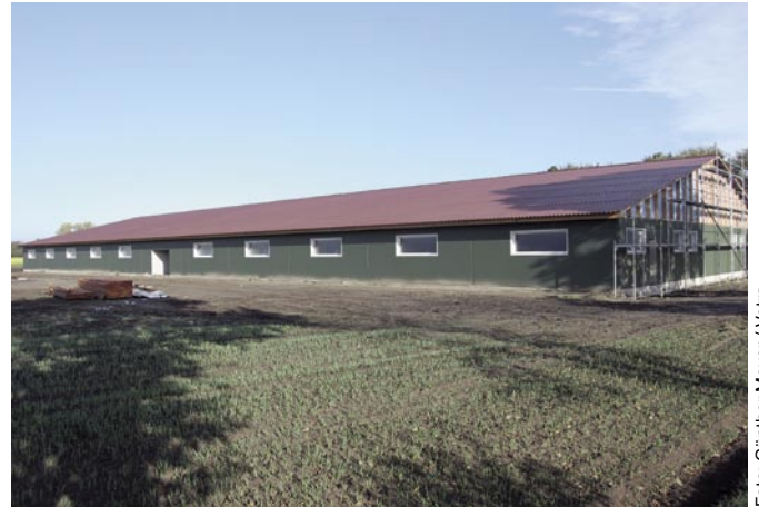
Bild 2: Sobald Agrarwände und Dachverkleidungen verbaut sind, ist das Gebäude in seiner Grundsubstanz bereits fertig.
