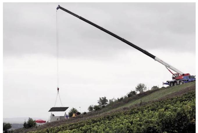
Bild 5: Aufsetzen der Dachplatte mit einem Mobilkran
