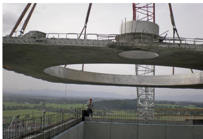
Bild 8: Einheben des Deckenfertigteils mittels Autokran
