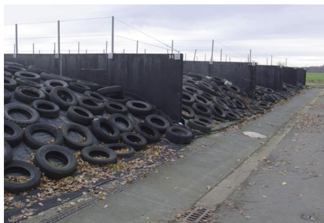
Bild 1: Beim Bau von Fahrsiloanlagen muss die ordnungsgemäße Ableitung des Niederschlagswassers geplant werden.
