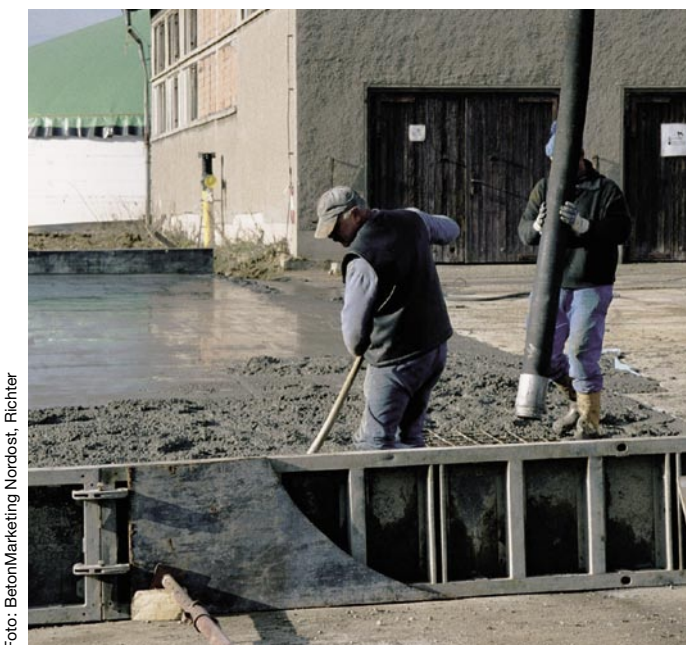
Bild 8: Betonieren einer Hofffläche mit Transportbeton
