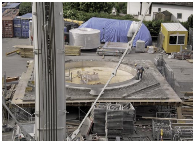
Bild 7: Deckenfertigteil mit diagonal verlaufenden Aufkantungen zum Anheben
