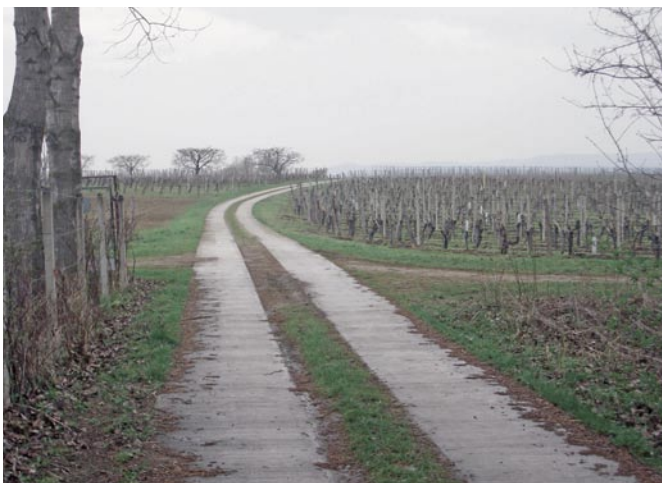
Bild 2: Betonspurweg Horitschon im Burgenland
