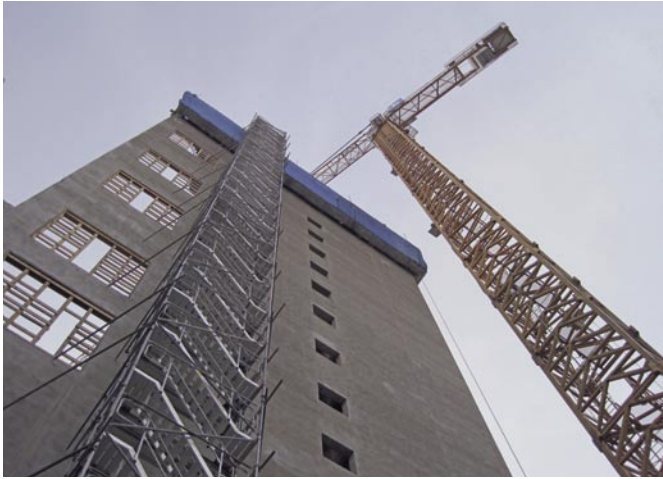
Bild 4: Herstellung des Treppenhauskerns mittels Gleitschalungstechnik
