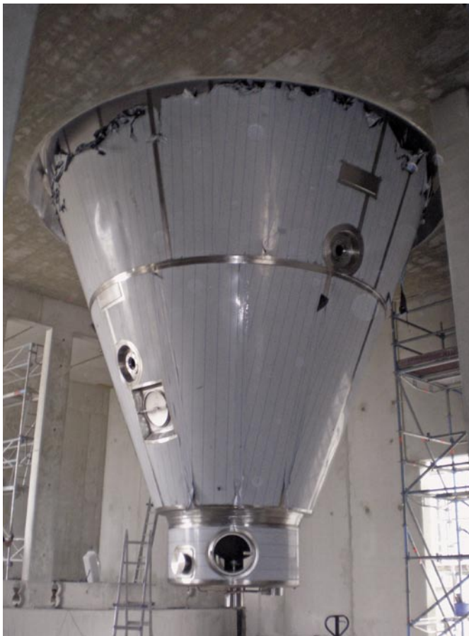
Bild 6: Anlagenteil, bereits während der Ausführung der Rohbaumaßnahmen integriert
