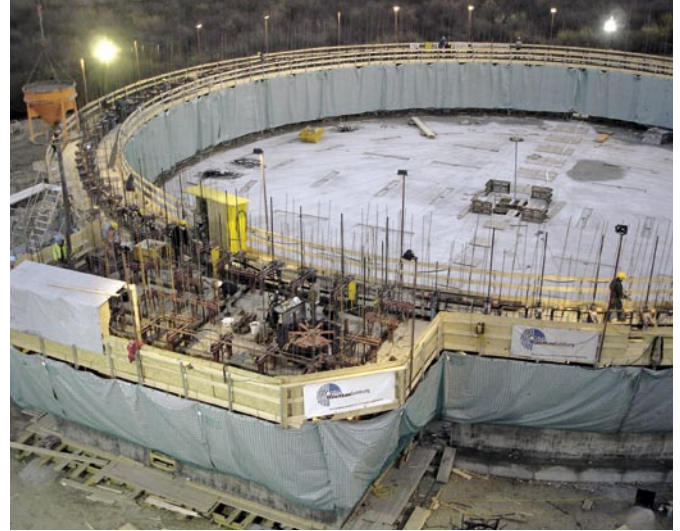
Bild 4: Beginn der Gleitschalungsfertigung der Wände
