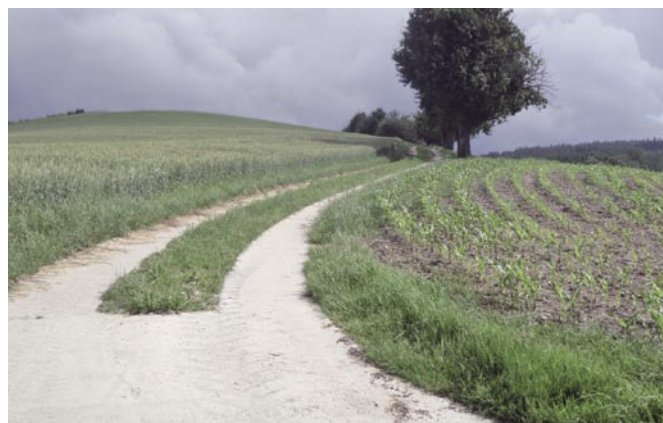
Bild 5: Begrünter Betonspurweg „Dallinger“, Oberösterreich
