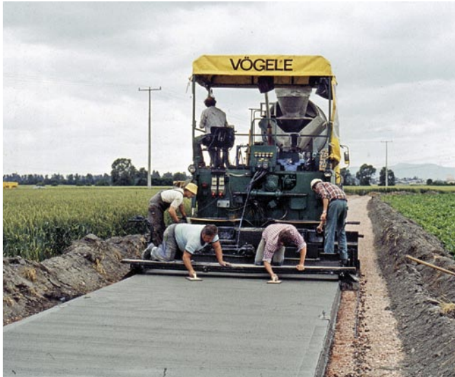
Bild 4: Herstellung eines Ortbetonwegs mit einem Gleitschalungsfertiger
