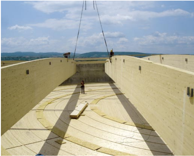
Bild 7: Verlegung der Dachträger
