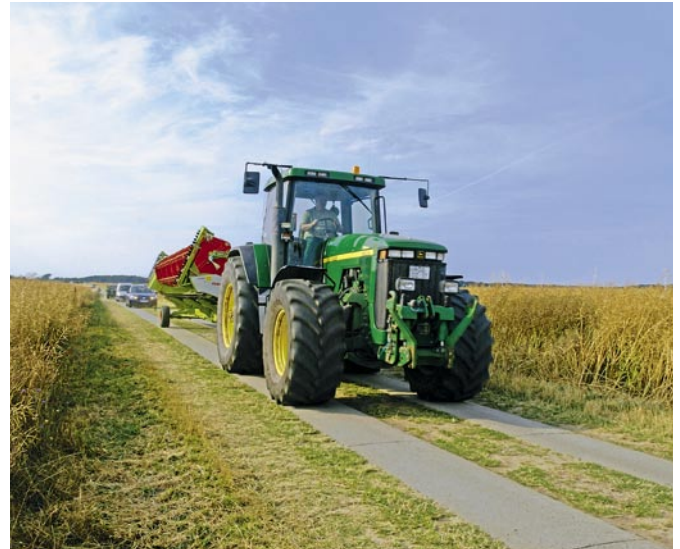
Bild 5: Ortbeton-Spurweg
