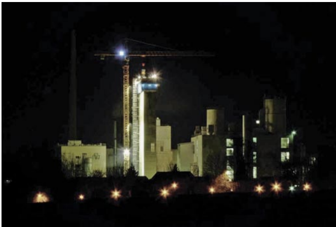
Bild 5: Gleitschalungsarbeiten während der Nacht
