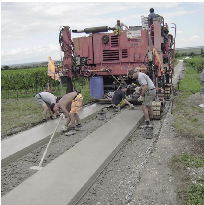
Bild 1: Spurwegeinbau mit Fertiger, Betonspurweg Rust/Oggau im Burgenland
