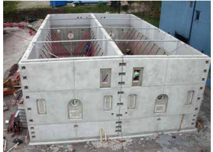
Bild 12: Rechteckiger Betonfertigteilfermenter in der Bauphase
