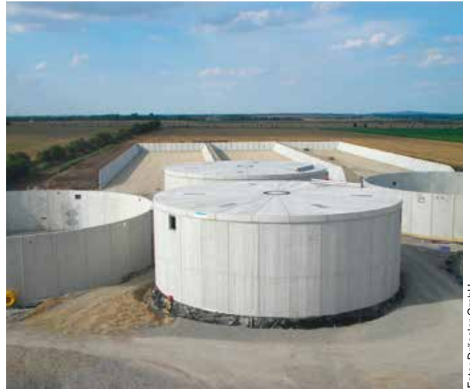
Bild 6: Abdeckung von Behältern mit Stahlbetonfertigteilen
