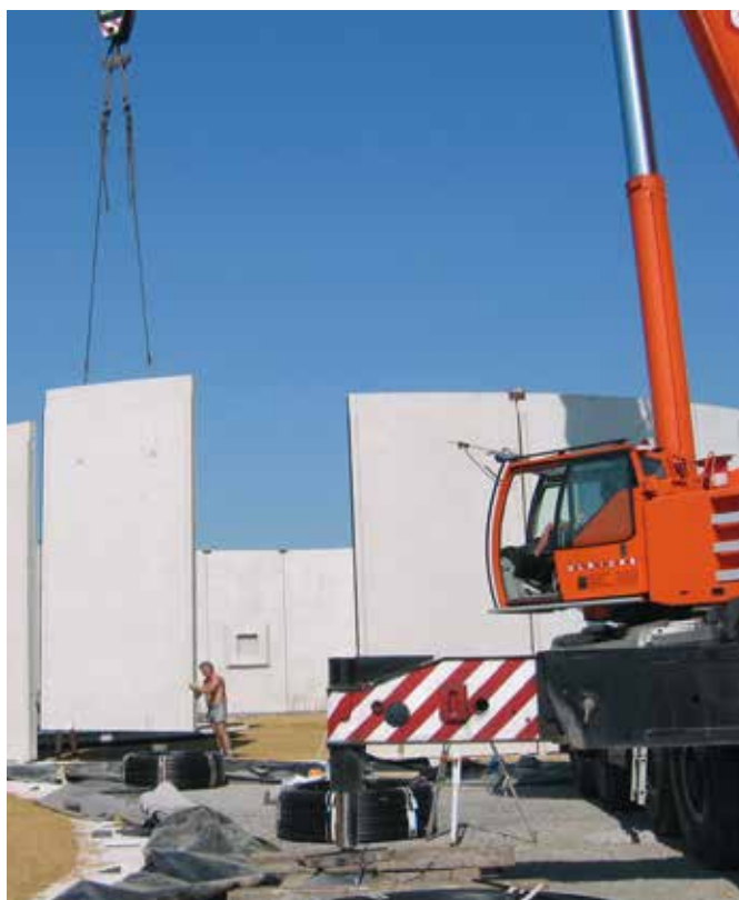
Bild 4: Montage von angerundeten Wandelementen für eine Biogasanlage als Betonfertigteile
