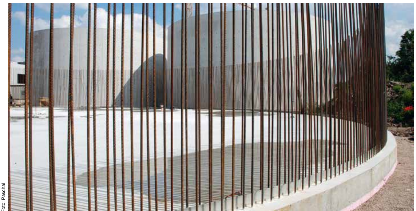
Bild 10: Anschluss Bodenplatte/Behälterwand mit Fugenblech und Anschlussbewehrung
