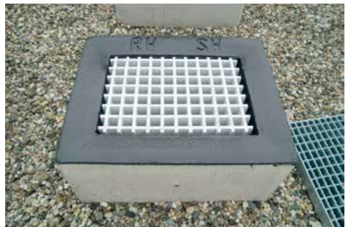
Bild 3: Je nach Bewirtschaftungsphase leitet das Entwässerungselement ThermoDuo über den RW-Ablauf den Regen oder über den SW-Ablauf Sickersaft bzw. verschmutztes Regenwasser aus dem Silo.
