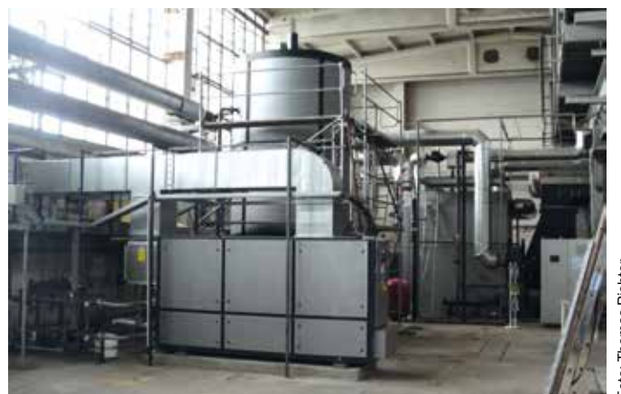
Bild 14: Heizhaus mit BHKW (Vordergrund), Pufferspeicher und Hackschnitzelkessel
