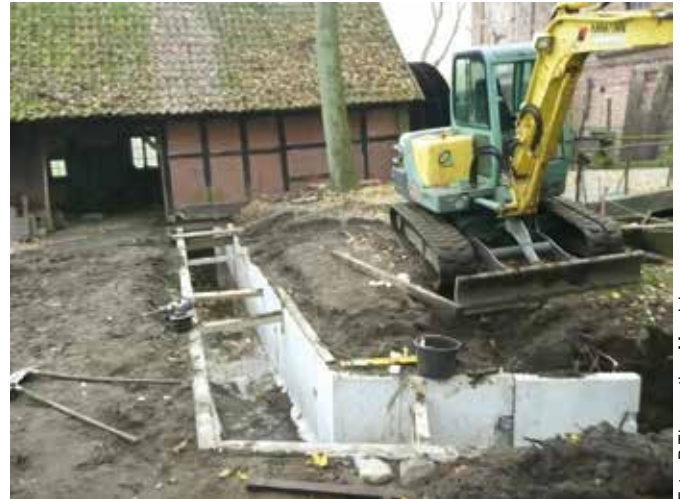
Bild 6: FAA während der Bauphase
