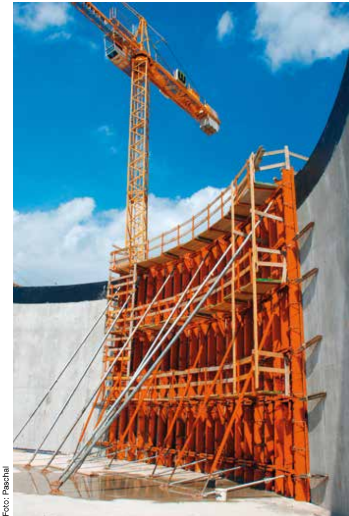
Bild 3: Stahlbetonbehälter aus Ortbeton für eine Biogasanlage in der Bauphase
