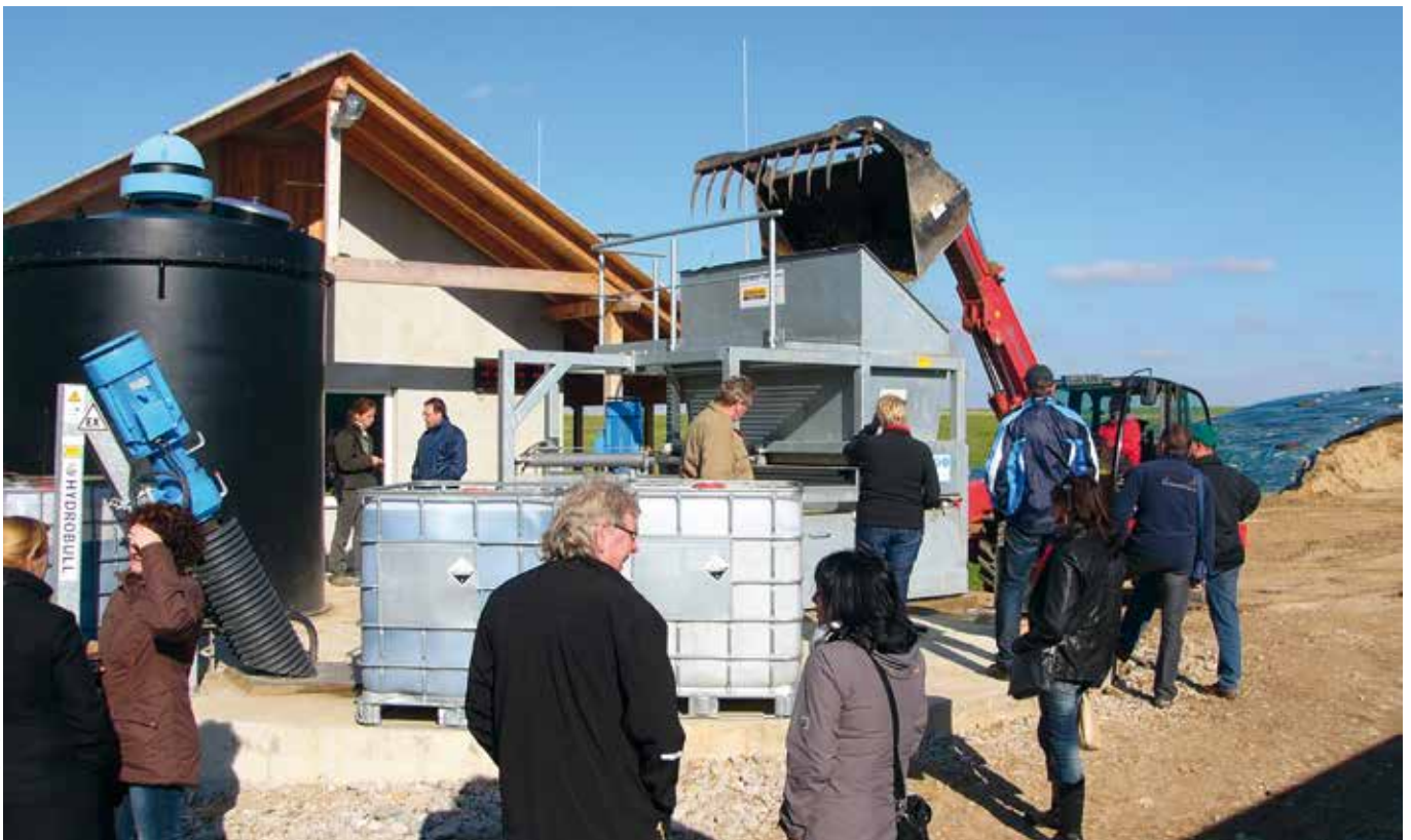
Bild 10: Hydrolyseschleuse der Biogasanlage, im Hintergrund Silagelager
