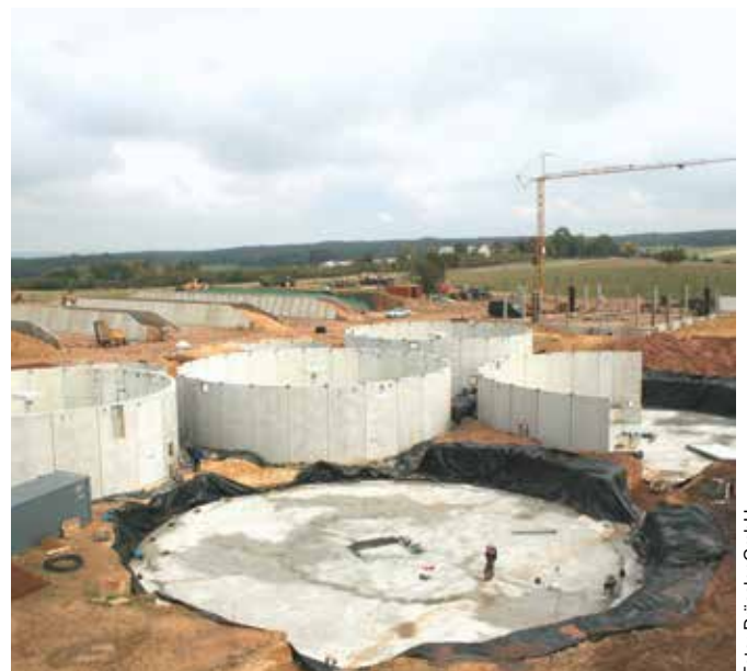
Bild 7: Behältergründung mit zweilagiger Folie
