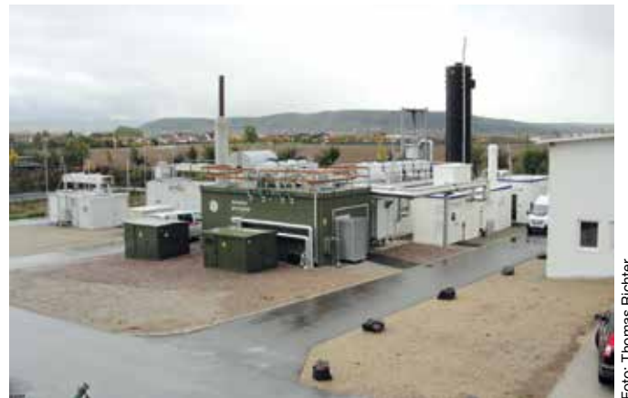
Bild 13: Biogasaufbereitung zu Biomethan
