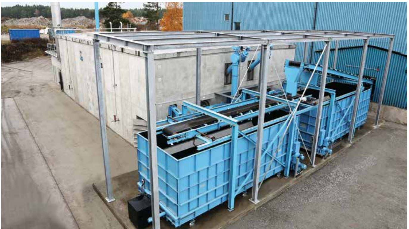
Bild 14: Rechteckiger Betonfertigteilvermenter nach der Fertigstellung
