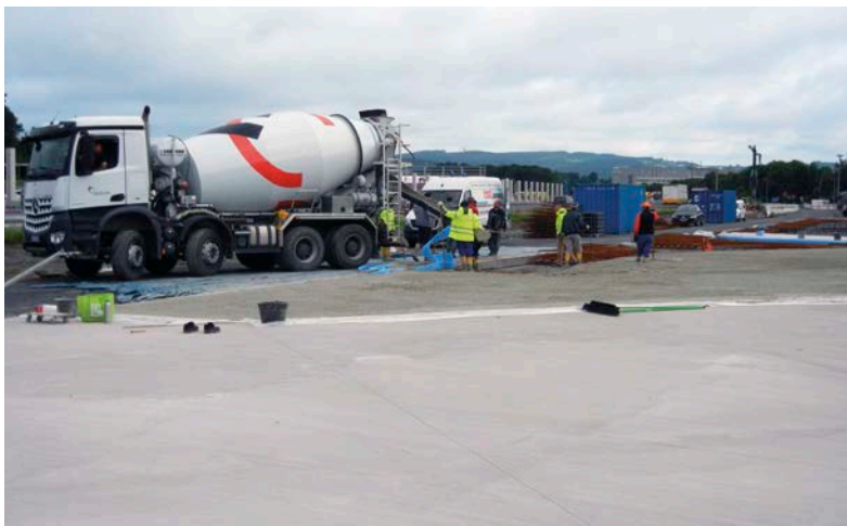
Bild 4: Nach Fertigstellung der Oberfläche wurde der Beton mit Folie abgedeckt.
