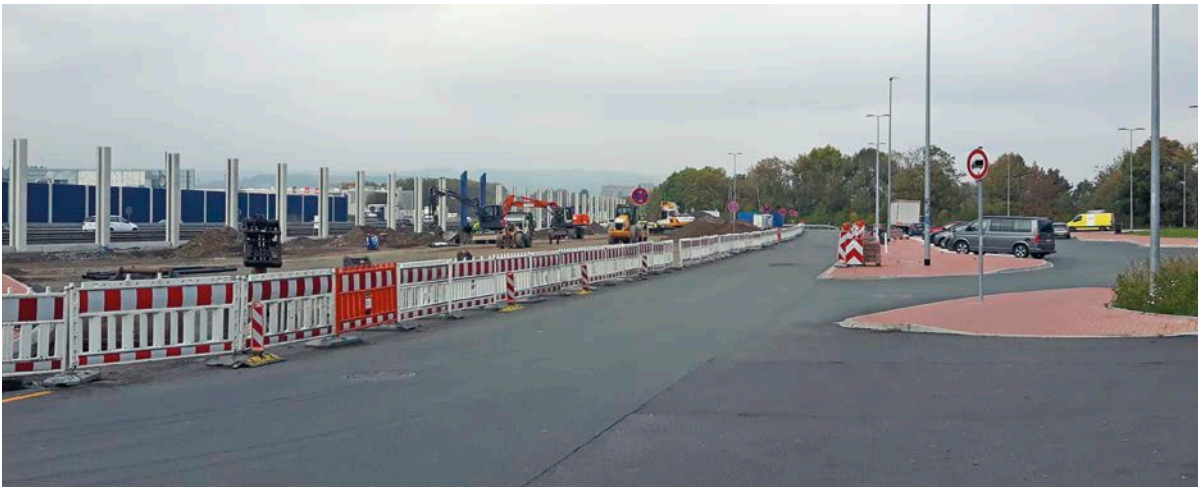
Bild 8: An der Raststätte Sauerland Ost wird in Teilbereichen noch gearbeitet.
