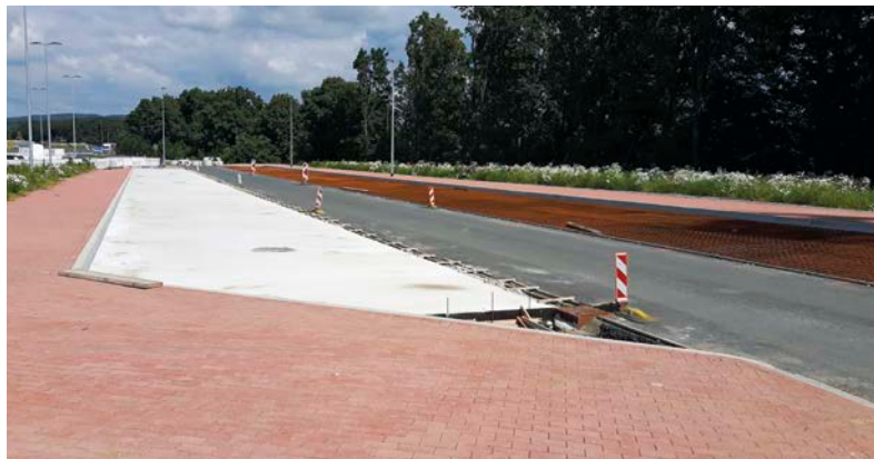
Bild 2: Alle Gehwege wurden aus rötlichen Betonpflastersteinen erstellt.
