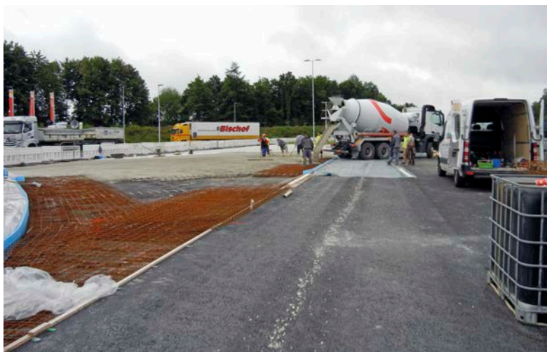
Bild 3: Betoneinbau und Bewehrung
