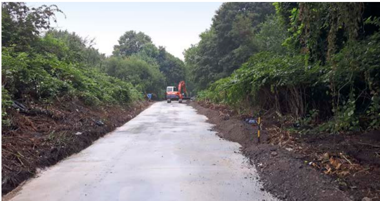
Bild 8: Arbeiten an der Bankette zur Randbefestigung der fertigen Werkstrasse
