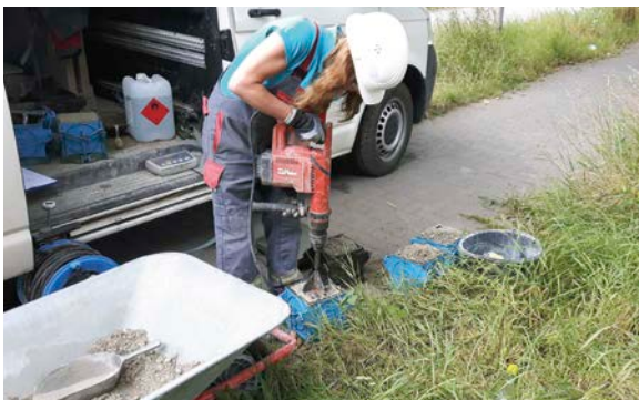
Bild 3: Herstellen der Prüfkörper mittels eines modifizierten Bohrhammers
