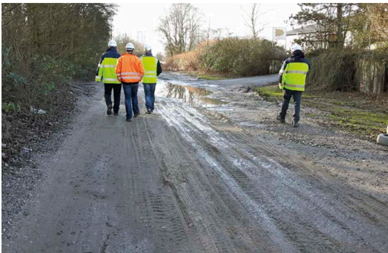
Bild 1: Werkstrasse vor der Sanierung
