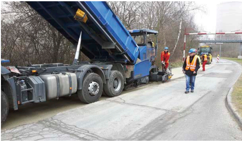
Bild 2: Anlegen einer Versuchsstrecke für den zweilagigen Einbau von Walzbeton
