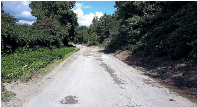
Bild 5: Gereinigter Untergrund mit gezogener Nivellierschnur
