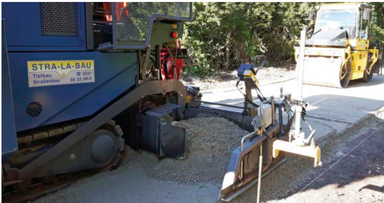
Bild 7: Einbau des Walzbetons mittels Straßenfertiger mit anschließendem Walzen
