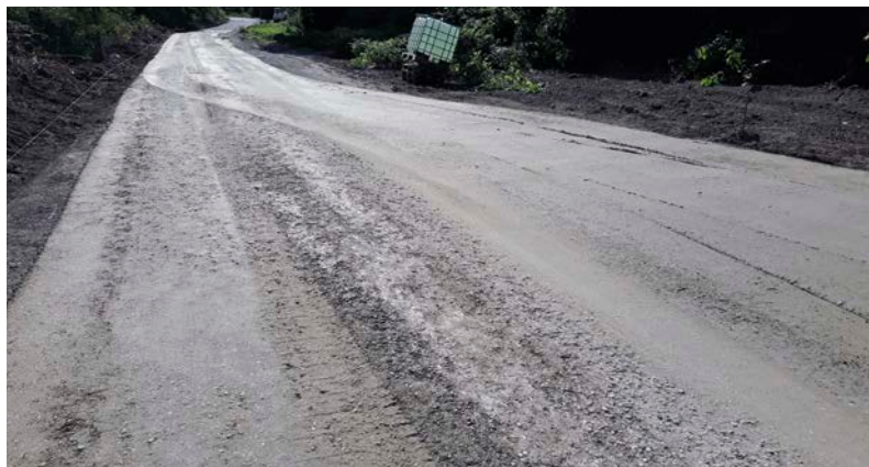
Bild 6: Erste Schicht zum Ausgleich von starken Unebenheiten
