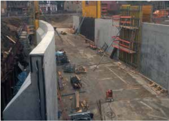
Bild 3: Schalung des Trogbauwerks Nord
