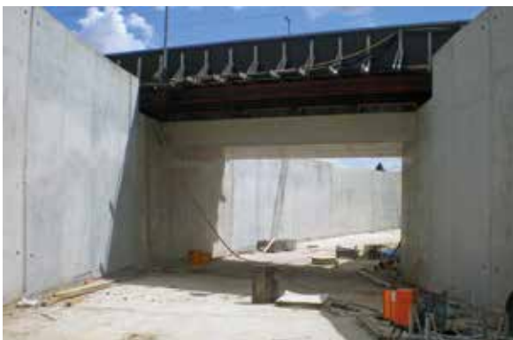
Bild 11: Ansicht der Eisenbahnüberführung
