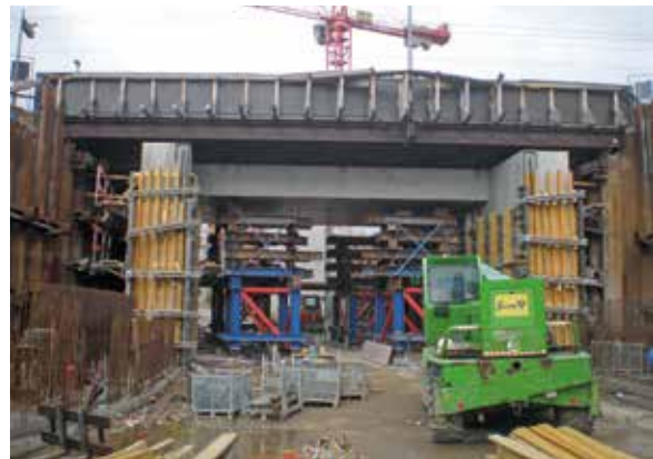
Bild 8: Betonage der Eisenbahnüberführung
