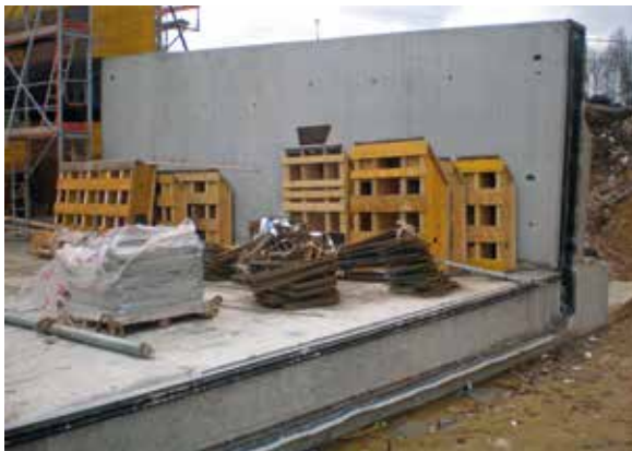
Bild 7: Detail der Schalung des Trogbauwerks
