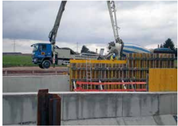
Bild 4: Betonage des Trogbauwerks
