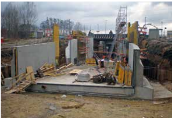
Bild 5: Schalung des Trogbauwerks Süd
