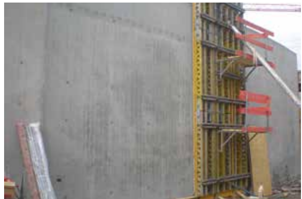
Bild 6: Detail der Trogwand
