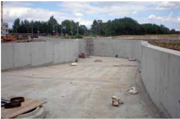
Bild 9: Ansicht des Trogbauwerks Süd
