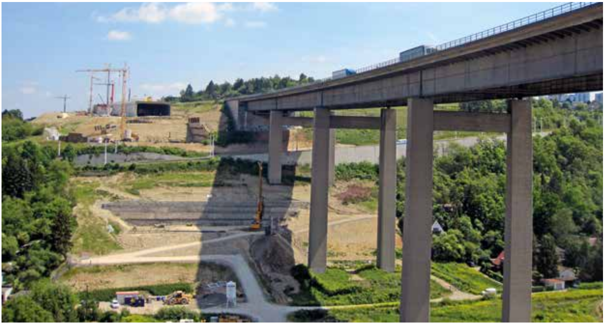
Bild 2: Die bestehende Talbrücke Heidingsfeld; im Hintergrund ist der im Bau befindliche Katzenbergtunnel zu sehen.
