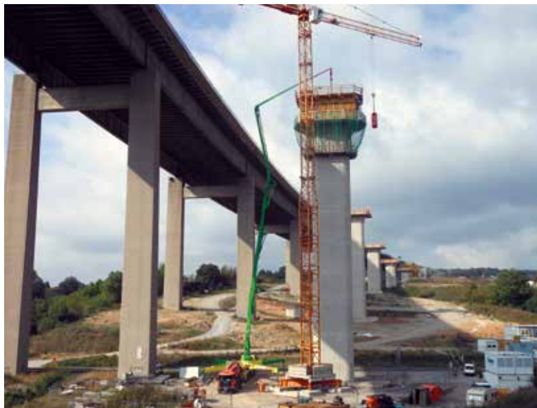
Bild 4: Betonage eines Pfeilerkopfes (C40/50) mit einer 63-m-Pumpe
