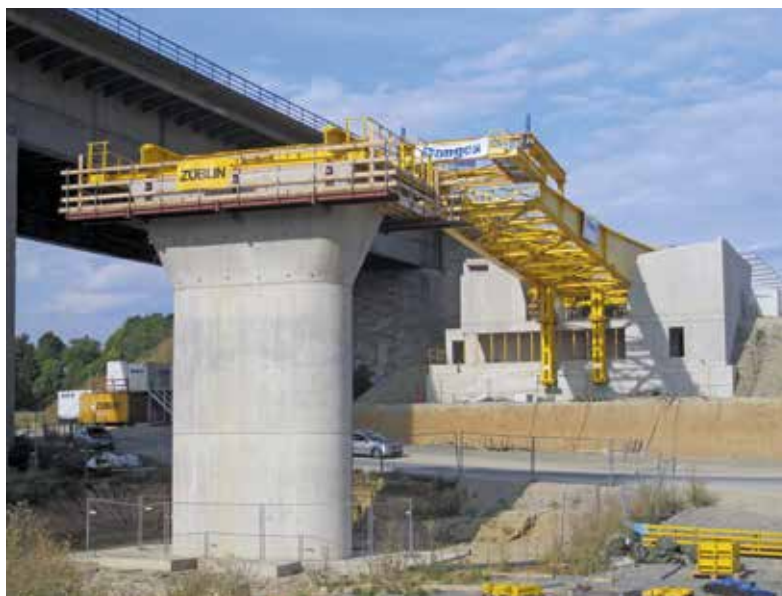
Bild 5: Westliches Widerlager mit Taktkeller
