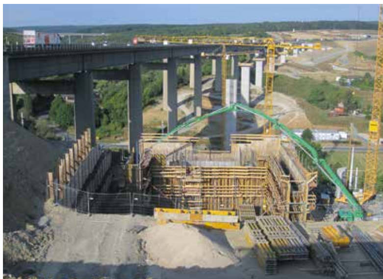
Bild 8: Herstellung des östlichen Widerlagers der Richtungsfahrbahn Frankfurt
