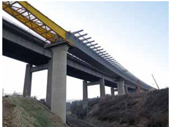
Bild 7: Stahlhohlkasten nach dem Verschieben des zweiten Abschnitts
