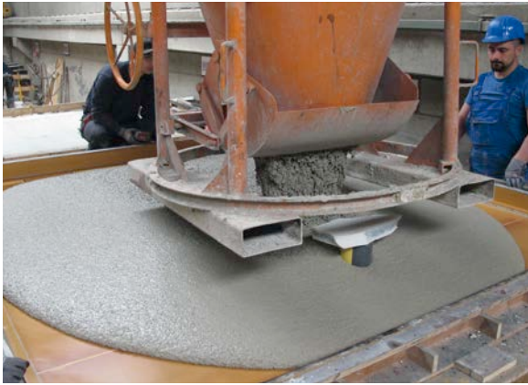
Bild 12: Betonage mit dem selbstverdichtendem UHPC
