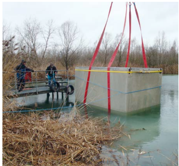
Bild 6: Betonponton aus verklebtem Hochleistungsbeton
