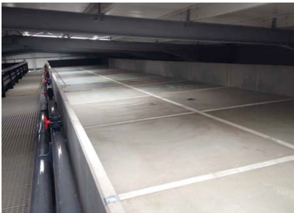
Bild 16: Fertiggestelltes oberes Becken
