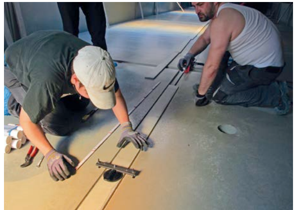
Bild 15: Stoßfugenausbildung
