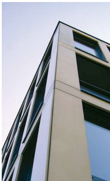
Bild 10: Vorhangfassade einer Firmenzentrale in Gummersbach
