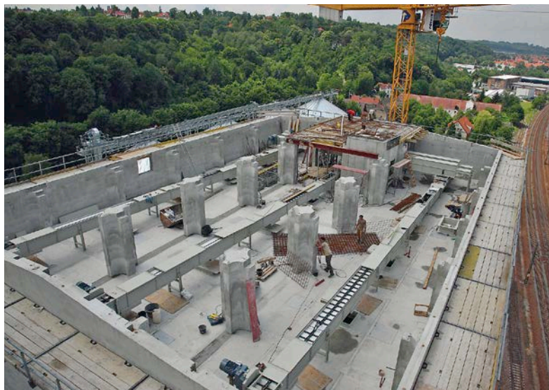
Bild 2: Die 13 Silokammern werden durch Zwischenwände voneinander getrennt.
