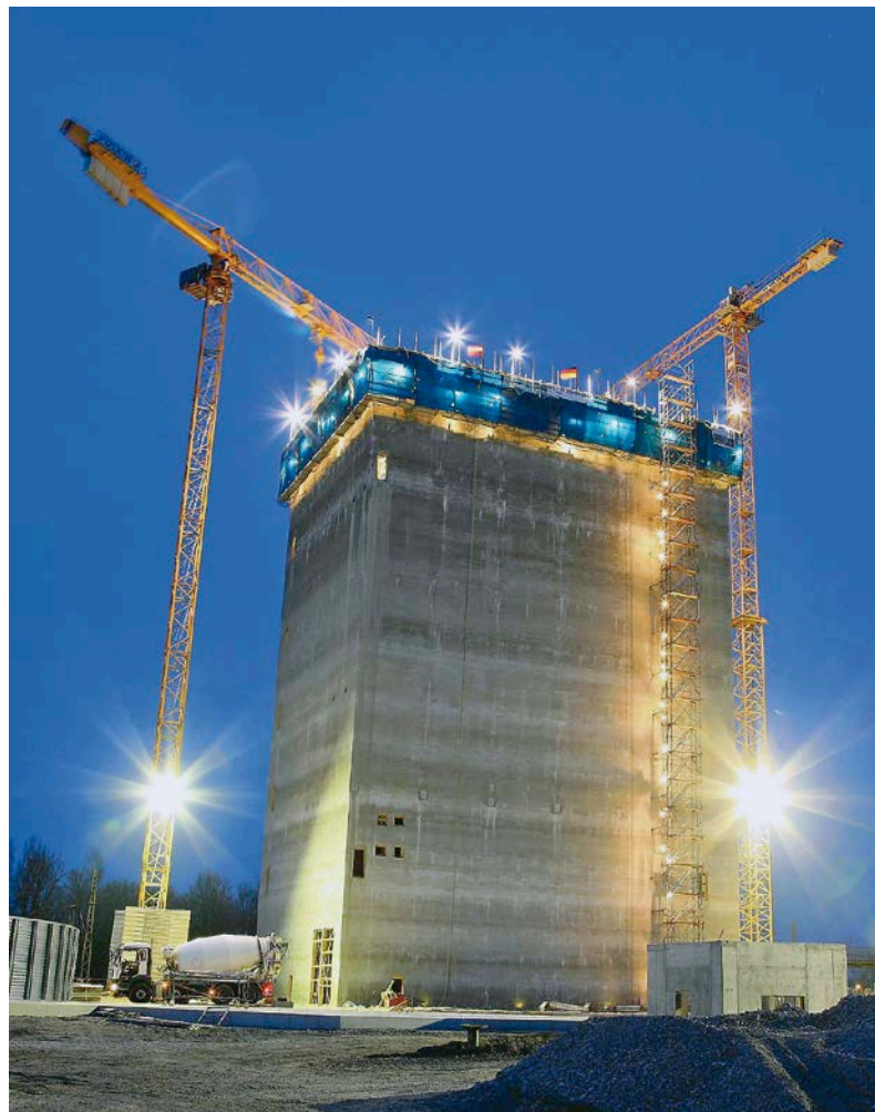
Bild 4: Zwei Kräne hoben die Spezialkübel mit Beton Tag und Nacht bis zum Einbauort.
