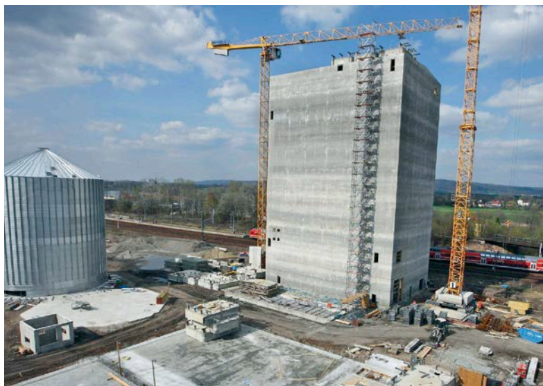
Bild 3: Bis auf 46 m Höhe wurde der Baukörper mit einer Gleitschalung betoniert.
