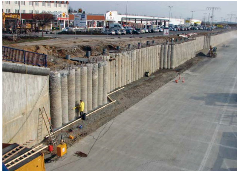
Bild 1: Bohrpfehlwand
