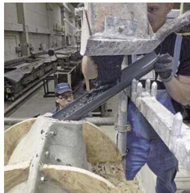
Bild 5: Betonage eines Teils der Skulptur im Werk
