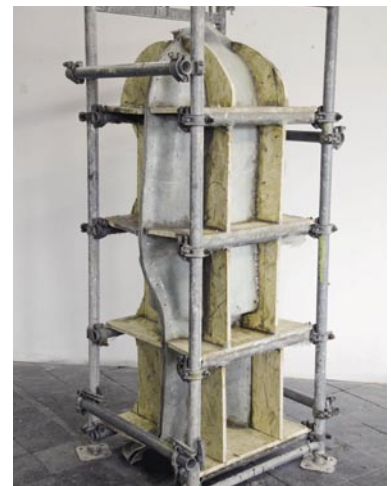
Bild 4: Die transportfähige Schalung
