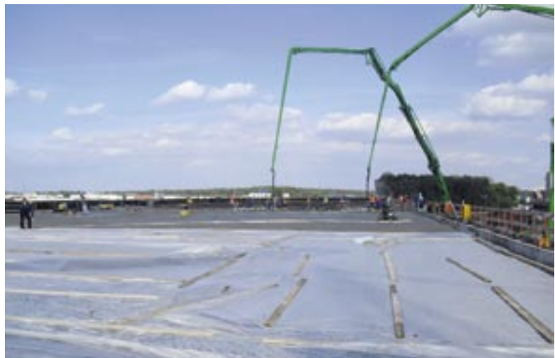
Bild 13: Der junge Beton wird mit Folien vor Witterungseinflüssen geschützt.
