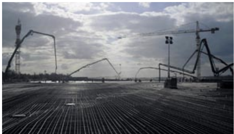
Bild 8: Insgesamt waren fünf Betonpumpen im Einsatz.
