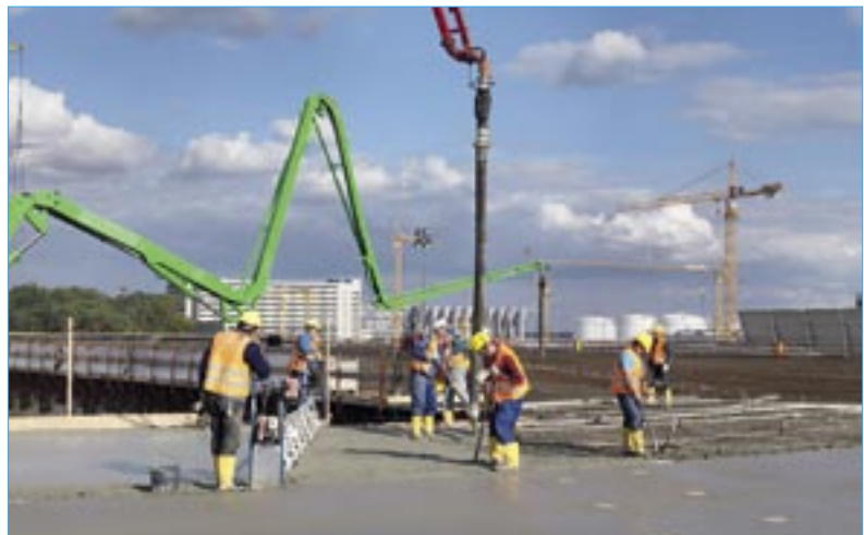
Bild 7: Frisch-in-Frisch-Einbau des Betons in den Seitenflanken
