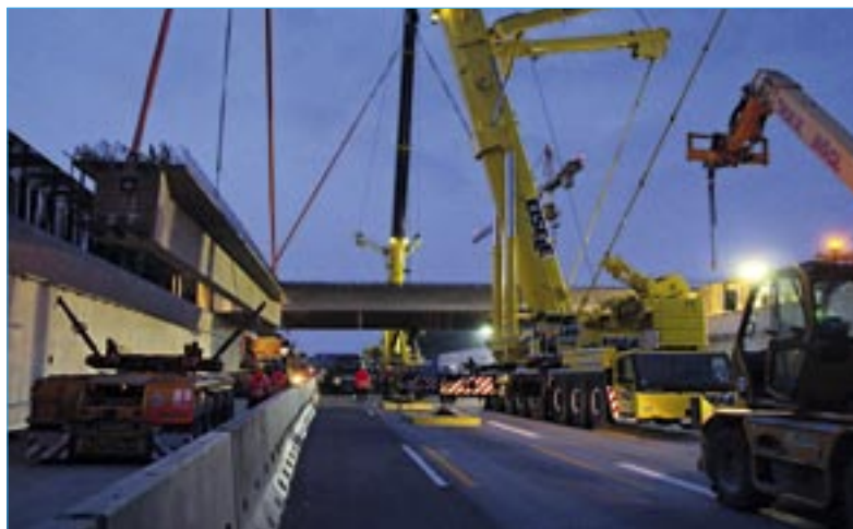
Bild 4: Einbau der Fertigteile in den Nachtstunden
