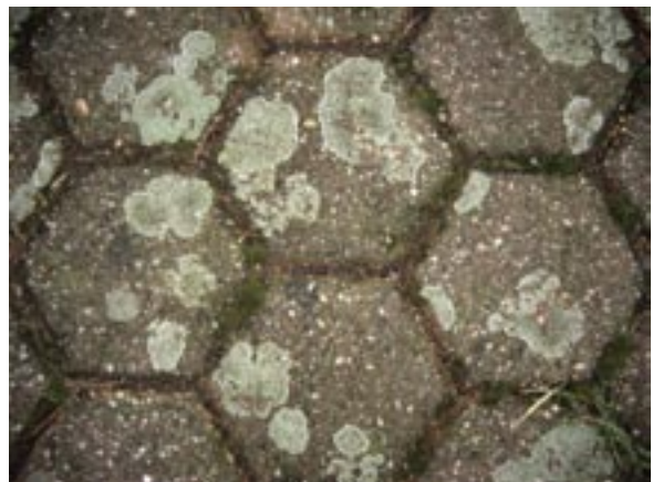
Bild 10: 3 Jahre nach der Verlegung mit Flechten überzogener Pflasterbelag
