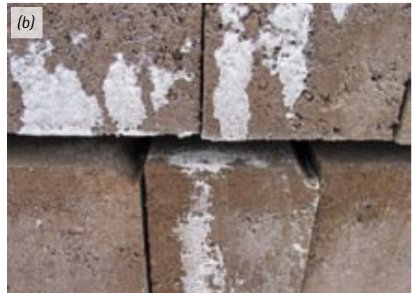
Bild 2: „Aussinterungen“ eines mineralischen Füllers auf Pflastersteinen; Ansicht von oben (a) bzw. von der Seite (b)
