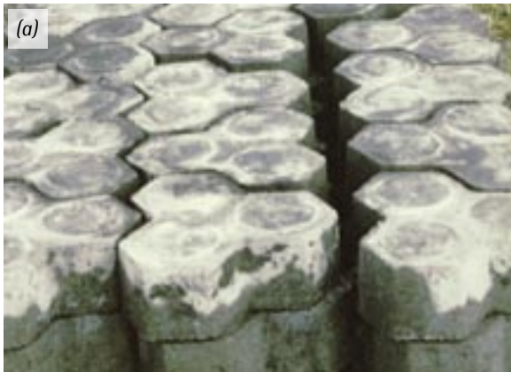
Bild 2: „Aussinterungen“ eines mineralischen Füllers auf Pflastersteinen; Ansicht von oben (a) bzw. von der Seite (b)
