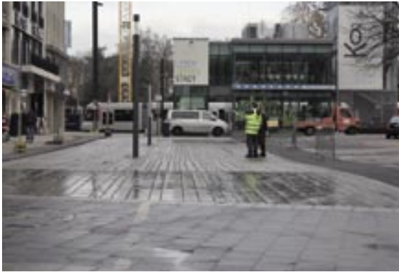
Bild 5: Musterpflasterflächen für den Kö-Bogen in Düsseldorf im „Stresstest“
