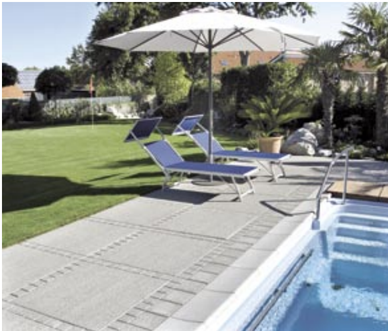
Bild 3: Großformatige Platten kombiniert mit Pflastersteinen sind interessante Gestaltungsmittel für Flächenbefestigungen.
