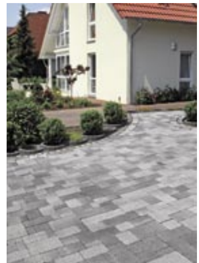
Bild 7: Die Verwendung haufwerksporiger Pflastersteine ermöglicht die Versickerung von Regen- und Schmelzwasser und trägt zum Umweltschutz bei.
