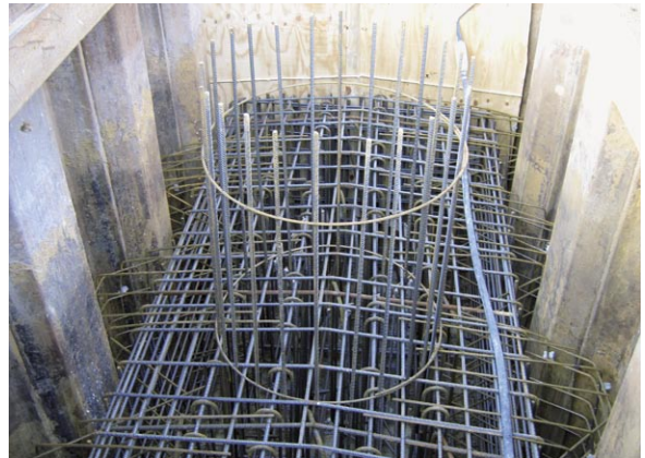
Bild 4: Bewehrungsdetails beim Fundament des Mittelquerträgers
