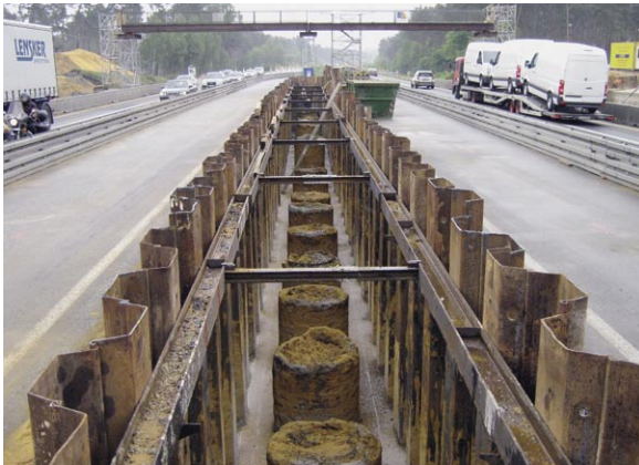
Bild 3: Blick auf die Bohrpfähle für den Mittelquerträger
