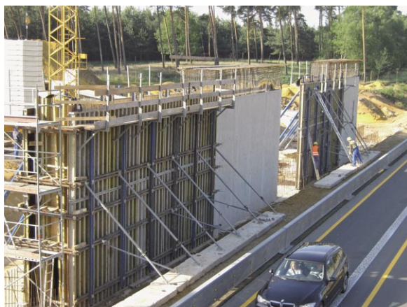
Bild 6: Ein Widerlager entsteht in kleinen Schritten, jeder Abschnitt hat eine Länge von 10 m
