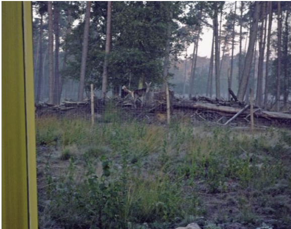
Bild 10: Die künftigen Nutzer beobachten kritisch das Treiben auf der Baustelle.
