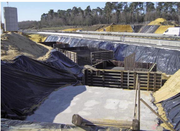
Bild 1: Vorbereitung der Fundamentabschnitte im Pilgerschrittverfahren
