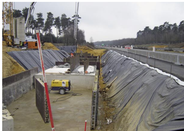
Bild 2: Betonage eines Fundamentabschnitts
