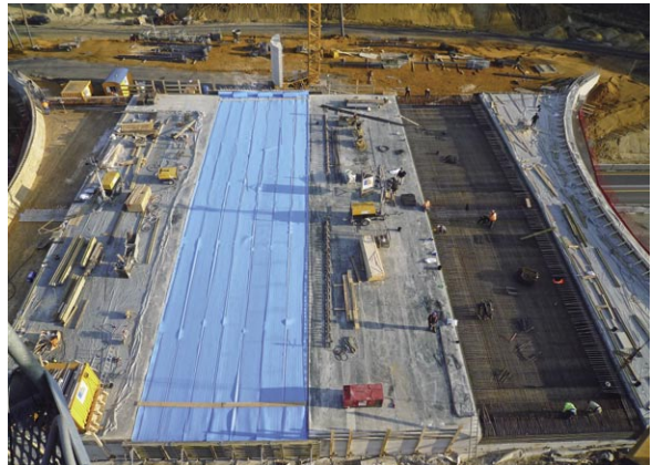
Bild 9: Blick vom Kran auf den im Pilgerschrittverfahren erstellten Überbau, Nachbehandlung: Abdeckung mit PE-Folie und dämmenden Matten
