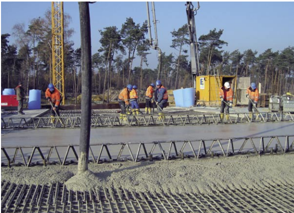
Bild 8: Einbau des Betons in den Überbau von zwei Seiten
