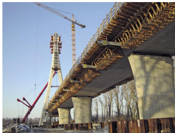
Bild 15: Überbau mit Pfeileranschluss und Pylon
