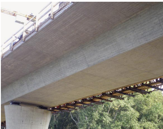
Bild 14: Untersicht Überbau mit Pfeileranschluss
