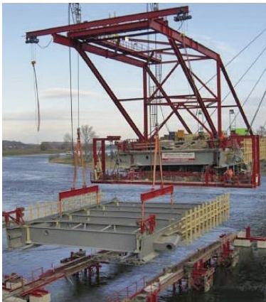
Bild 16: Einbau Stahlkonstruktion Strombrücke
