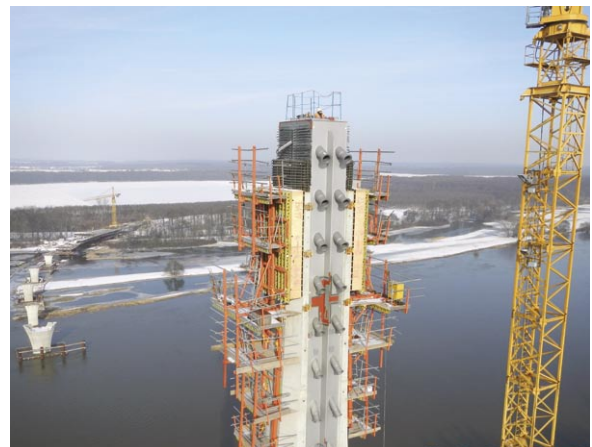
Bild 12: Detail des Pylons
