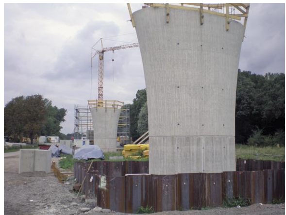
Bild 9: Vorlandpfeiler während der Herstellung
