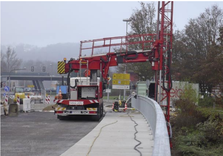
Bild 5: Instandsetzung der Donaubrücke Laizerstraße in Sigmaringen
