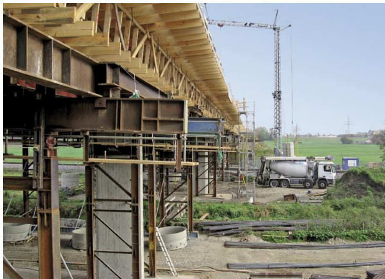
Bild 8: Betonierarbeiten im Zuge der Ortsumgehung Herbertingen, Brücke BW3
