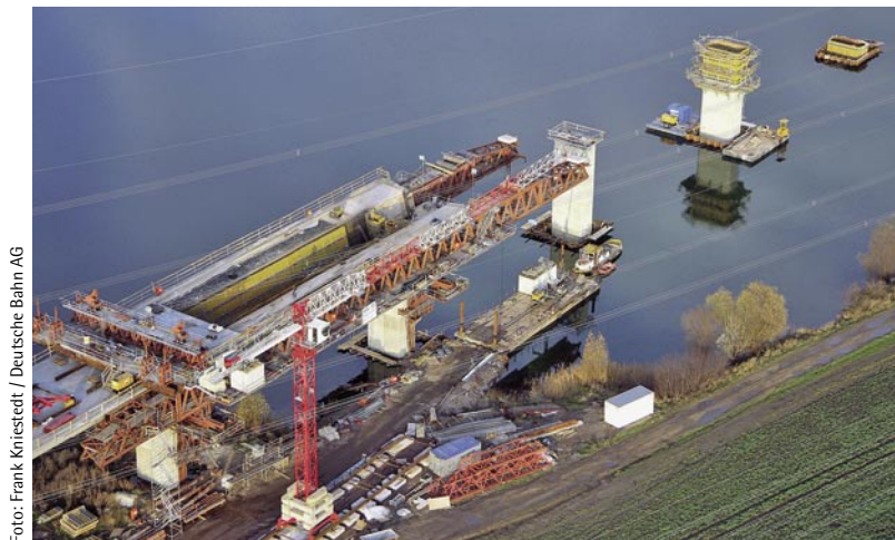
Bild 2: Bau der Saale-Elster-Talbrücke mit einer Gesamtlänge von fast 9 km
