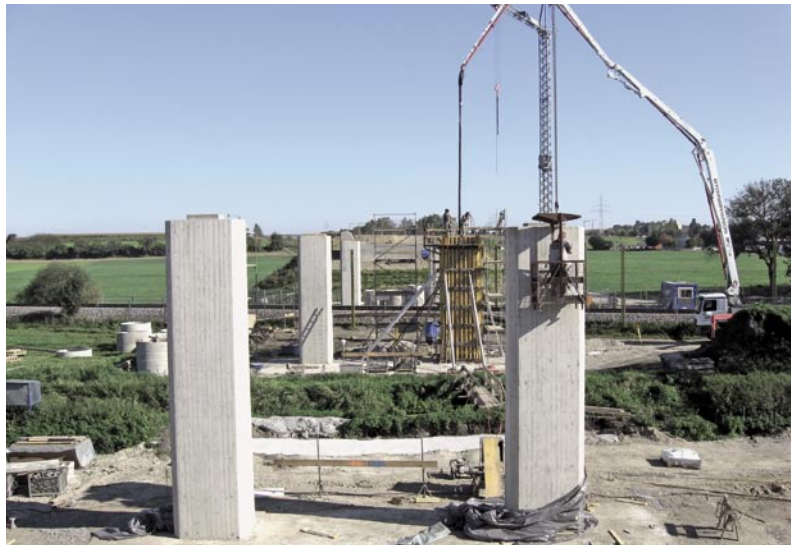
Bild 7: Betonieren der Brückenpfeiler im Zuge der Ortsumgehung Herbertingen
