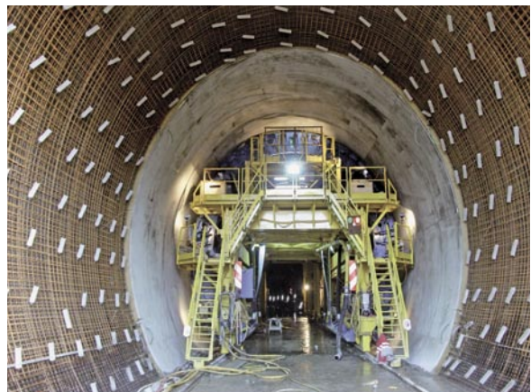
Bild 8: Vorbereitungsmaßnahmen zum Tunnelausbau
