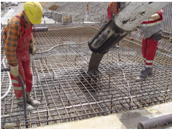
Bild 7: Betonierung der Sohlplatte
