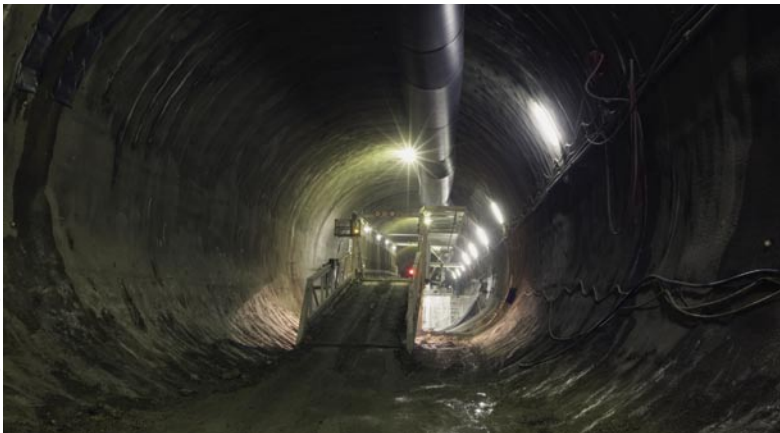
Bild 13: Sohlbrücke im Tunnel
