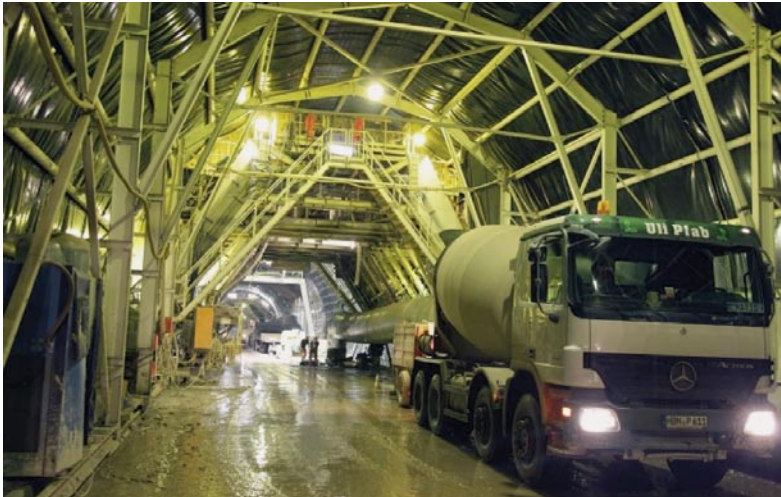
Bild 18: Einbau des Betons für die Innenschale des Gewölbes und Nachbehandlung
