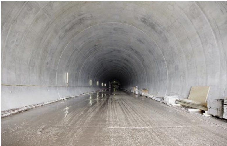
Bild 19: Fertiggestellte Innenschale
