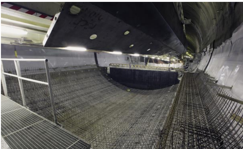
Bild 14: Einbringen der Sohlbewehrung unter der Sohlbrücke
