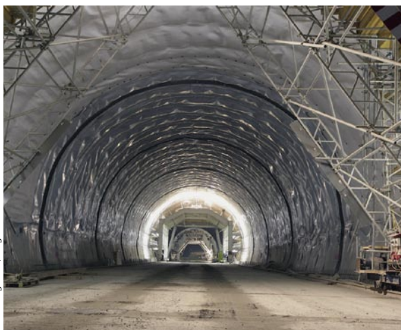
Bild 16: Abdichtung im Bereich des Gewölbes
