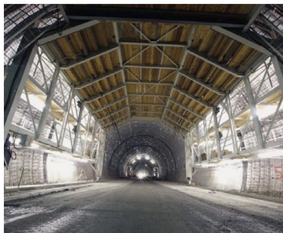
Bild 17: Bewehrung im Bereich der Innenschale des Gewölbes
