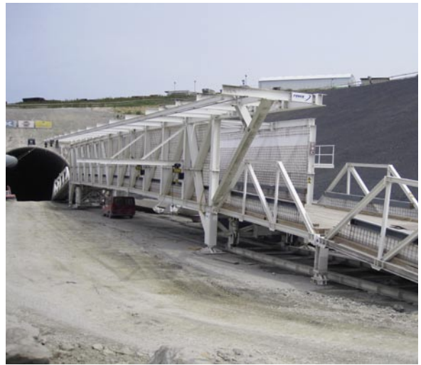
Bild 12: Sohlbrücke vor dem Tunnel
