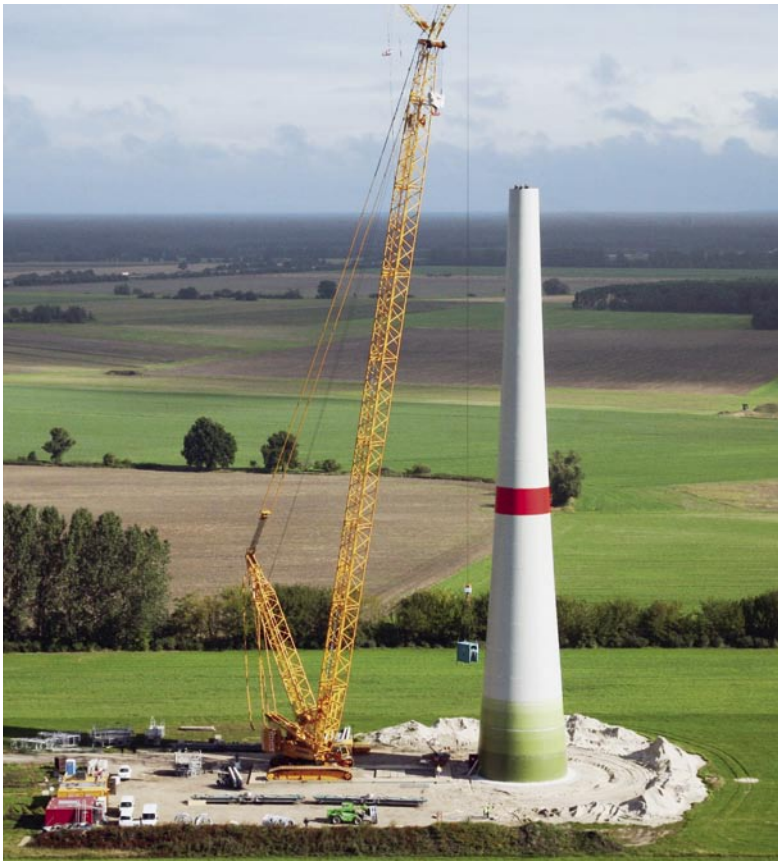
Bild 6: Bau der Windkraftanlage E-82 mit einer Nabenhöhe von 137 m
