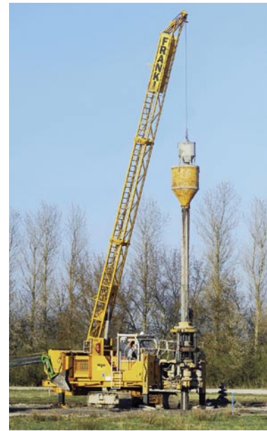
Bild 3: Die Auftriebssicherung der Unterwasserbetonsohle erfolgte mit Atlaspfählen.
