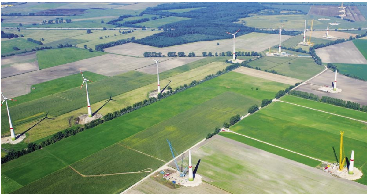
Bild 1: Der Windpark Schlalach in Brandenburg
