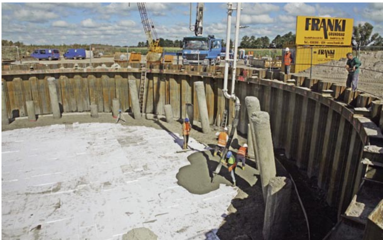
Bild 4: Betonage der Sauberkeitsschicht nach dem Gründungsvorgang
