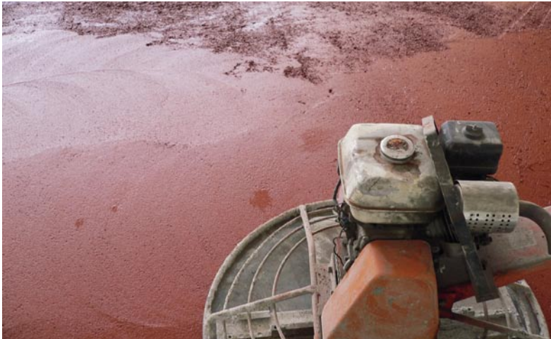
Bild 7: Glätten eines Designestrichs
