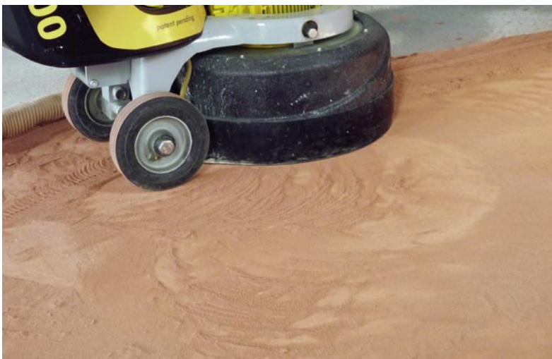
Bild 8: Bodenschleifmaschine auf Sand-Zementestrich
