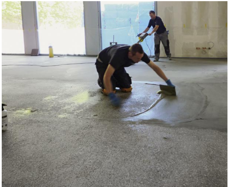
Bild 9: Spachtelarbeiten nach dem Grobschliff
