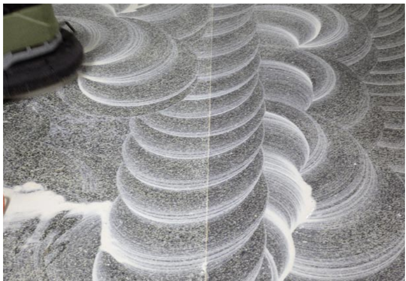
Bild 10: Abschließende Einpflege eines geschliffenen Estrichs
