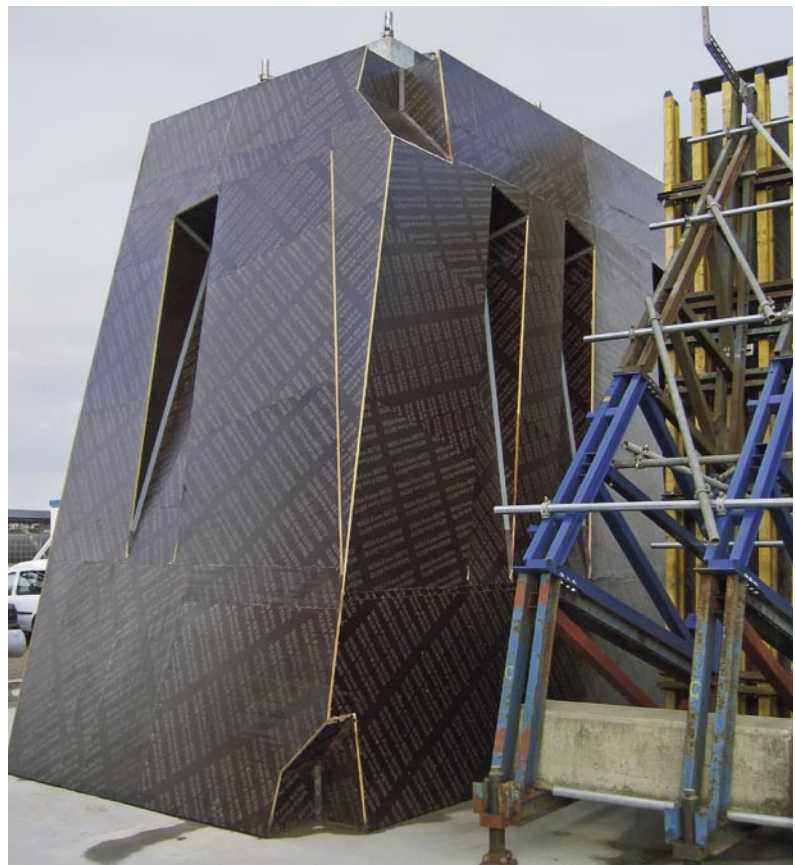
Bild 3: Teilansicht der handgefertigten Innenschalung für ein Segment
