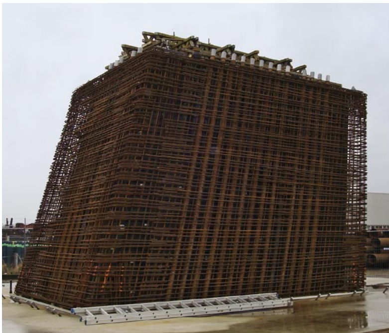
Bild 4: Fertige Bewehrung für ein Betonfertigteil
