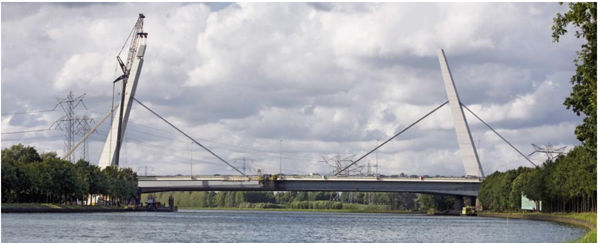
Bild 2: Montage des letzten Segments am zweiten Pylon
