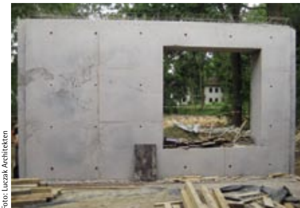
Bild 18: Leichte Blaufärbung nach dem Ausschalen
