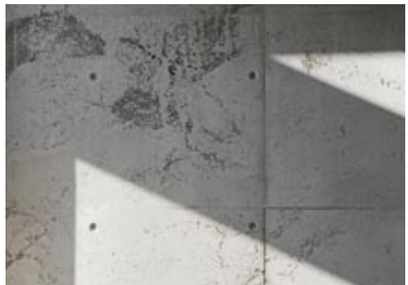
Bild 19: Organische Strukturen im Beton
