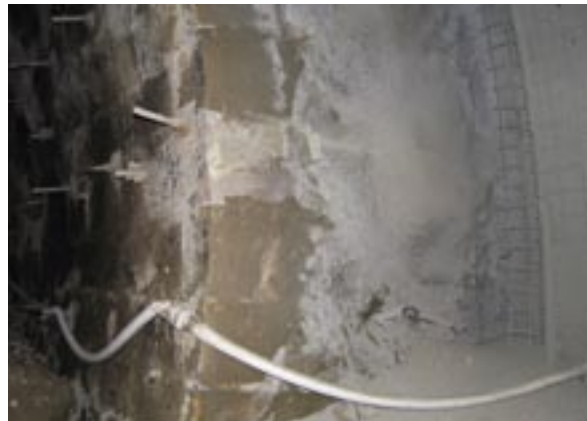
Bild 7: Ankerlage im Bereich des Vortriebs
