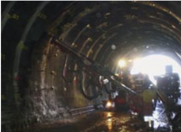
Bild 6: Einbringen der Anker und Verpressen des bestehenden Gewölbes
