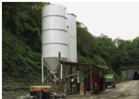
Bild 11: Baustellenmischanlage zur Suspensionsherstellung
