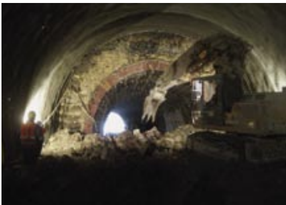
Bild 8: Vortrieb mittels Bagger
