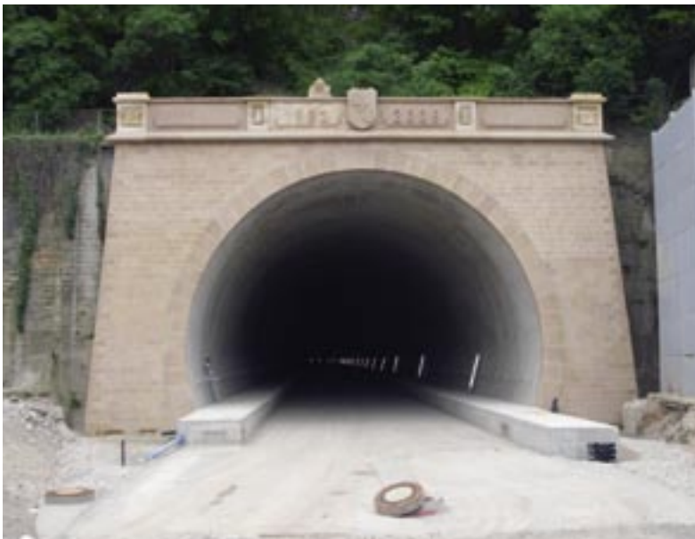
Bild 3: Portalbereich der Alten Mainzer Tunnel
