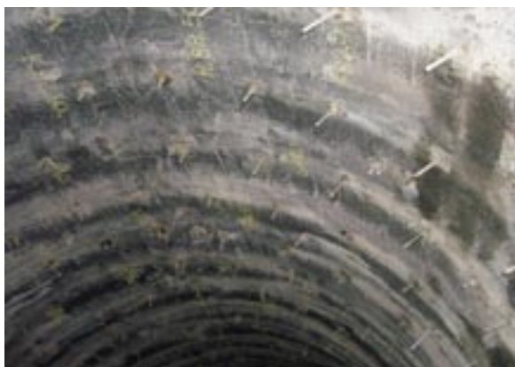
Bild 10: Raster der Anker im bestehenden Sandsteingewölbe
