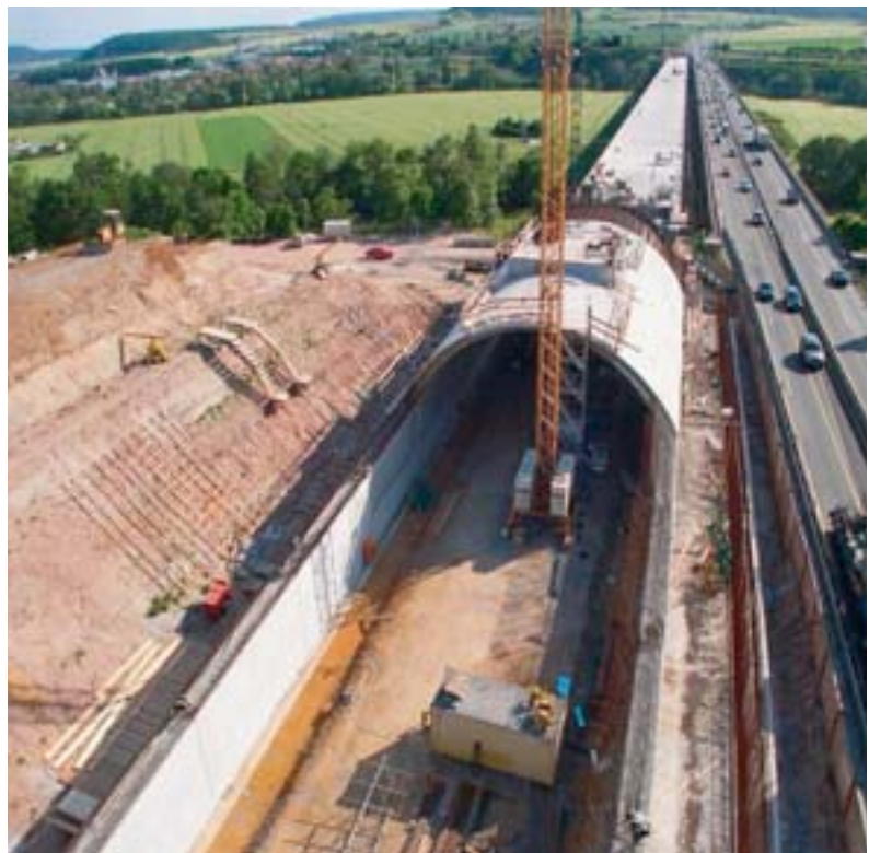
Bild 3: Betonierarbeiten an der Südröhre 2005
