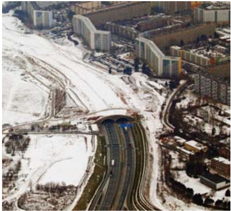
Bild 2: Überschütteter Lobdeburg-Tunnel im Februar 2010
