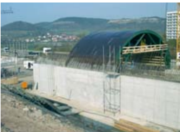
Bild 20: Schalwagen vor der Betonage eines Gewölbeblocks ( 180 \text{ m}^3 )
