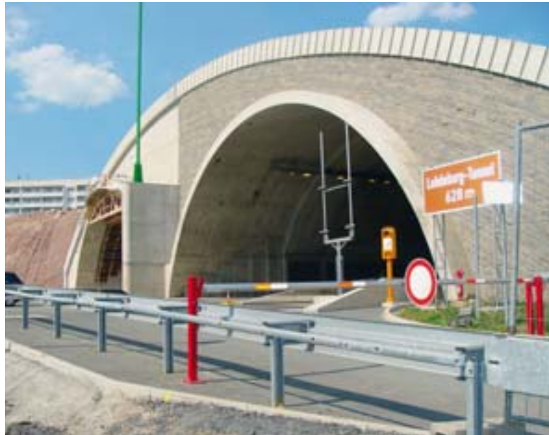
Bild 27: Westportal der Süd- und Nord-tubes des Lobdeburg-Tunnels
