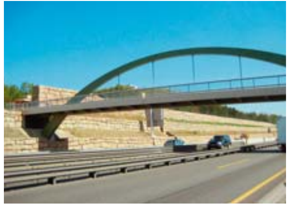
Bild 5: Geh- und Radwegbrücke am Lobe-Center als Ein-stabbogenbrücke mit einer Gesamtstützweite von 59 m
