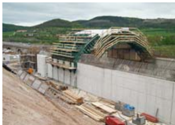
Bild 21: Schalwagen nach der Betonage eines Gewölbeblocks ( 180 \text{ m}^3 )
