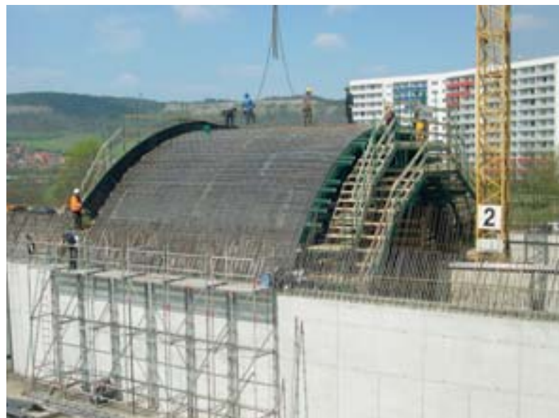
Bild 16: Vorbereitungen zur Betonage eines Gewölbeblocks
