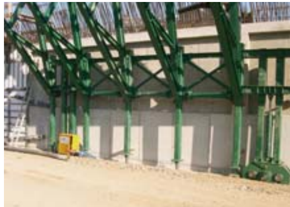
Bild 19: Räder und Hydraulik ermöglichen ein Verfahren des Schalwagens
