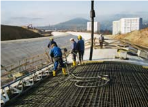
Bild 4: Letzter Betongang an der nördlichen Röhre des Lobdeburg-Tunnels zum Bogenschluss am 14.11.2008
