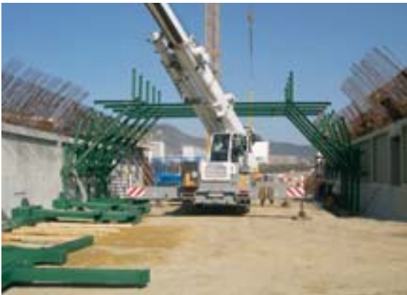
Bild 18: Aufbau des Schalwagens
