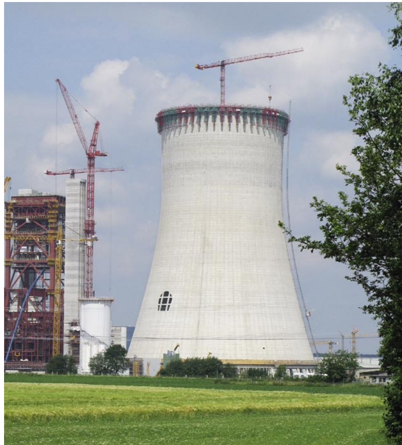
Bild 7: Der Naturzugkühlturm in Datteln während der Betonierarbeiten (Stand 10.06.2009)
