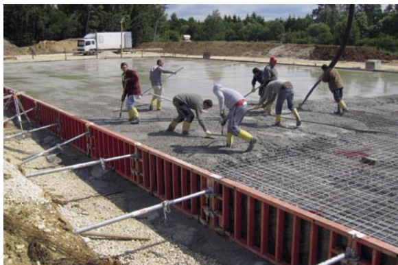
Bild 4: Einbau des Betons, Verdichten und Abziehen
