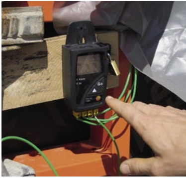
Bild 2: An der Schalung montierter Datenlogger
