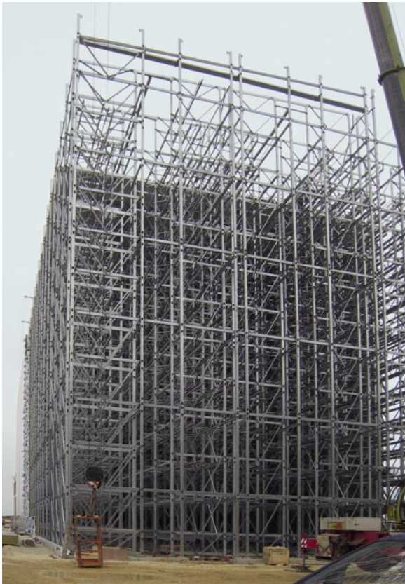
Bild 7: Hochregallager im Aufbau
