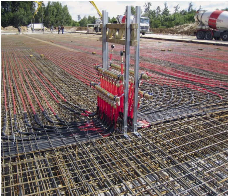
Bild 1: Obere Bewehrungslage und Installationen zur Betonkernaktivierung
