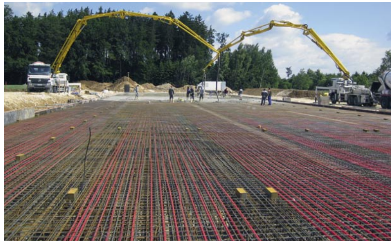
Bild 3: Betoneinbau für die Bodenplatte mit zwei Betonpumpen
