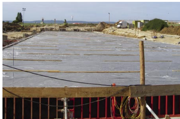
Bild 5: Nachbehandlung der betonierten Bodenplatte mittels Folie und durch Feuchthalten
