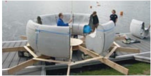
Bild 6: Stück für Stück wird der Ring zusammengesetzt.
