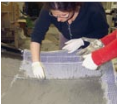
Bild 3: Der Feinbeton wird auf die textile Bewehrung aufgetragen.
