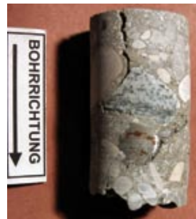
Bild 7: Risse bis zur Bewehrung, Fehlstelle unter der Bewehrung
