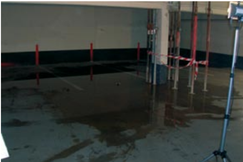
Bild 8: Beeinträchtigung der Gebrauchstauglichkeit durch Wasserpfützenbildung
