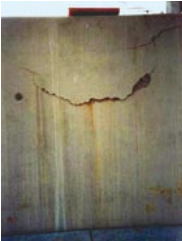
Bild 4: Frostsprengung einer Wand
