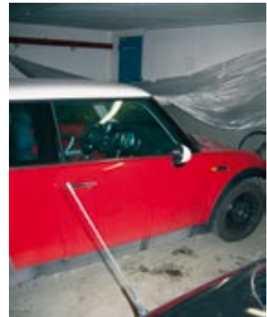
Bild 9: Verlust der Gebrauchstauglichkeit durch chloridhaltiges Wasser, das von der Decke tropft
