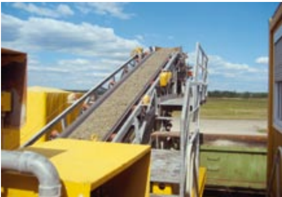
Bild 2: Übergabe des Deckenbetons auf Vierachser-Lkw mit Stahlmulde
