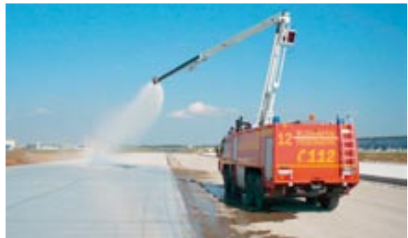
Bild 8: Zusätzliche Nass-Nachbehandlung über einen Zeitraum von 5 Tagen
