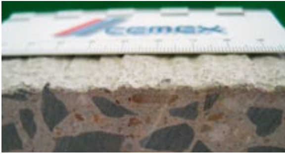
Bild 9: Querschnitt der Betondecke im oberen Bereich (Sägeschnitt an einer Tagesendfuge)
