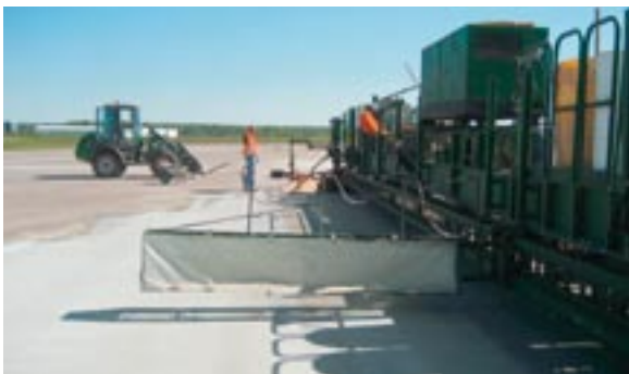
Bild 7: Maschinelles Auftragen des Nachbehandlungsmittels
