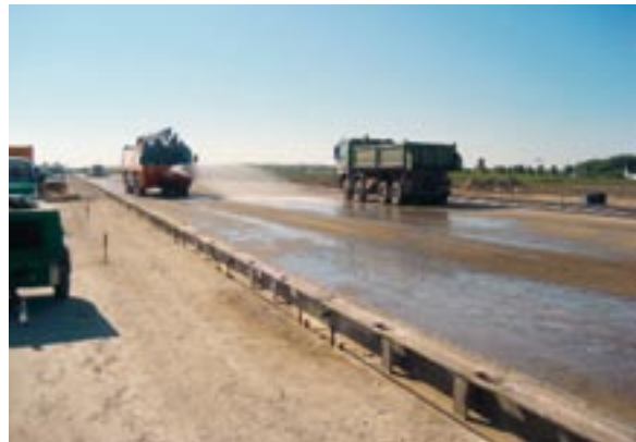
Bild 3: Vornässen der Tragschicht, um einen Entzug des Wassers aus dem Deckenbeton zu vermeiden
