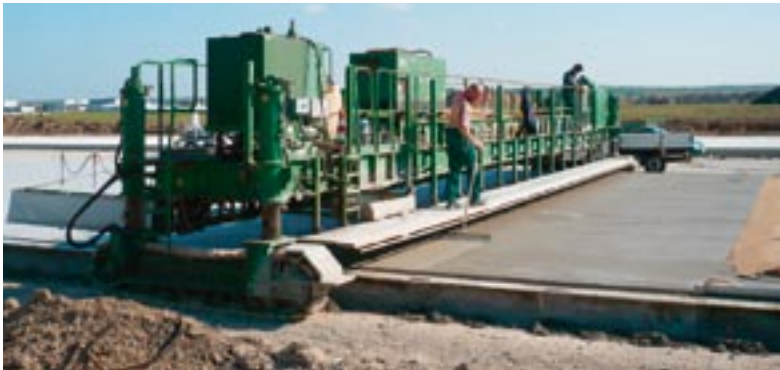
Bild 6: Strukturierung der mit einem Jutetuch abgezogenen Betondecke mit einem Querbesenstrich von einer selbstfahrenden Arbeitsbühne aus
