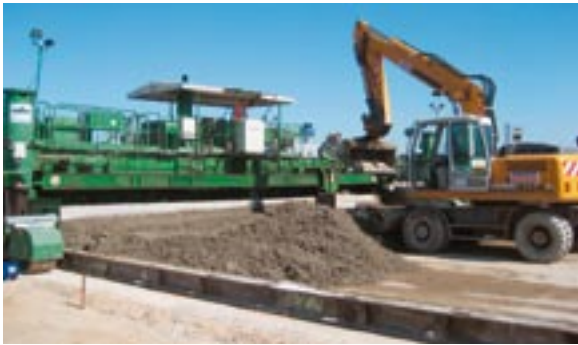
Bild 4: Verteilung und Vorprofilierung des angelieferten Betons mit Mobilbagger und Verteilerschwert
