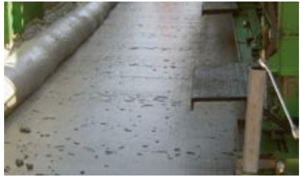
Bild 5: Eine gleichmäßige „Mörtelrolle“ vor dem Querglätter ist wichtig für einen optimalen Deckenschluss
