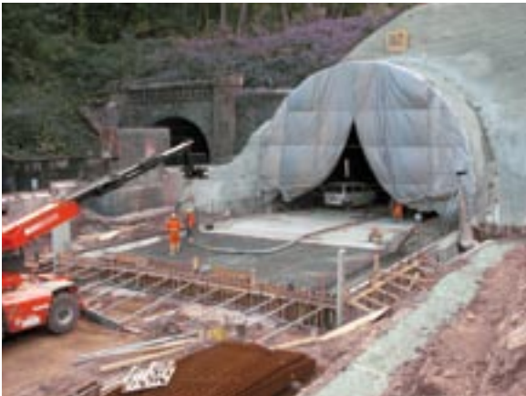
Bild 8: Einbau der Sohlblöcke in offener Bauweise
