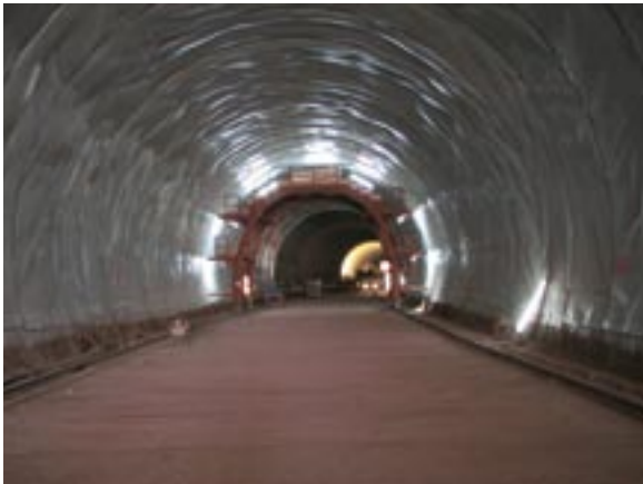
Bild 13: Folientrennschicht zwischen Außen- und Innenschale
