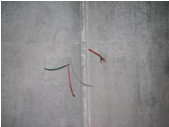
Bild 17: Injektionsschläuche zum nachträglichen Verpressen möglicher Undichtigkeiten
