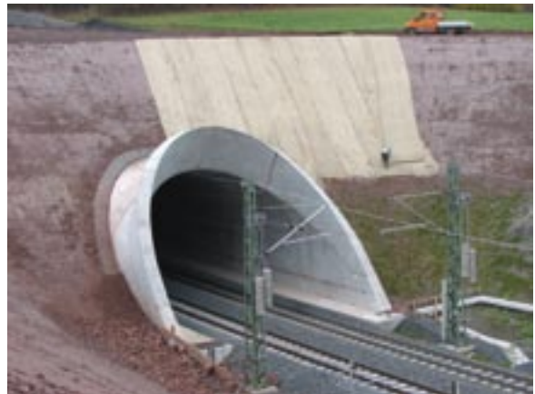
Bild 20: Fertiggestellter Ramholz-Tunnel im November 2008
