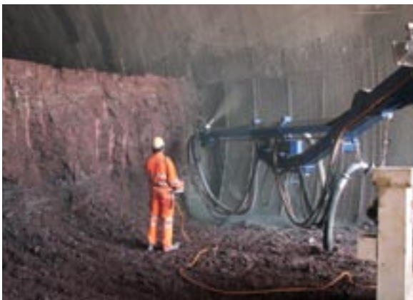
Bild 4: Spritzbetonauftrag
