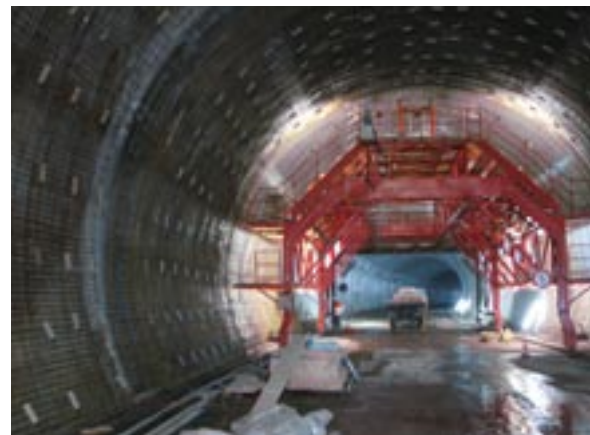
Bild 12: Einbau der Bewehrung
