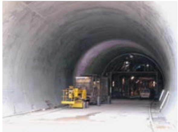
Bild 18: Innenschalenbeton
