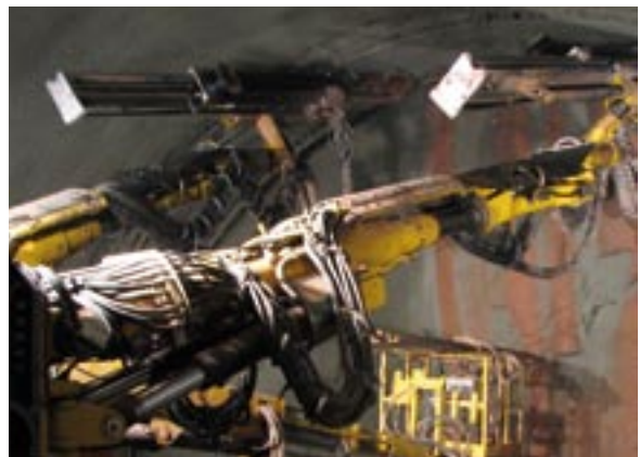
Bild 5: Bohren der Spieße mit dem Bohrwagen
