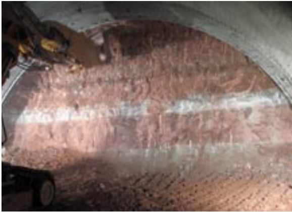
Bild 2: Ortsbrust beim Kalottenvortrieb
