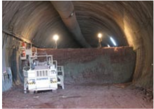
Bild 3: Strossenvortrieb
