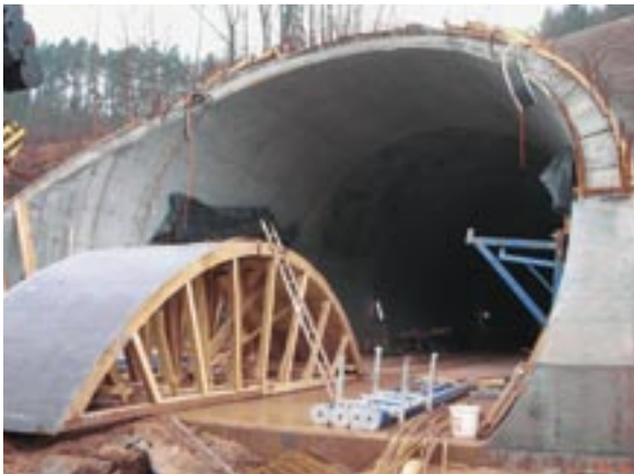
Bild 19: Baumaßnahmen am Portal
