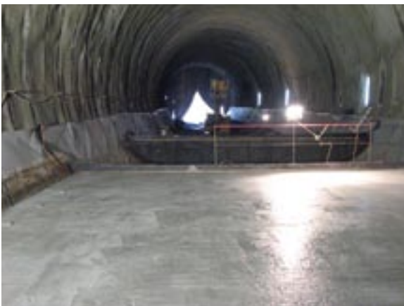
Bild 11: Betonierter Sohlblock
