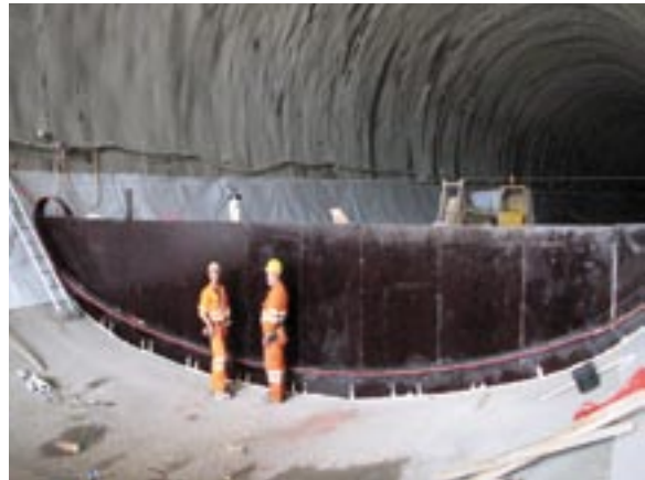
Bild 9: Schalung eines Sohlgewölbeblocks
