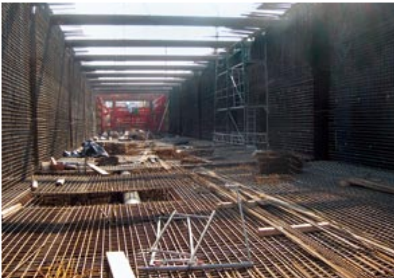
Bild 6: Bewehrte Sohle und Wände
