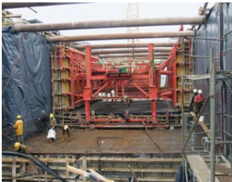
Bild 9: Blick auf den Holzträger-Schalwagen
