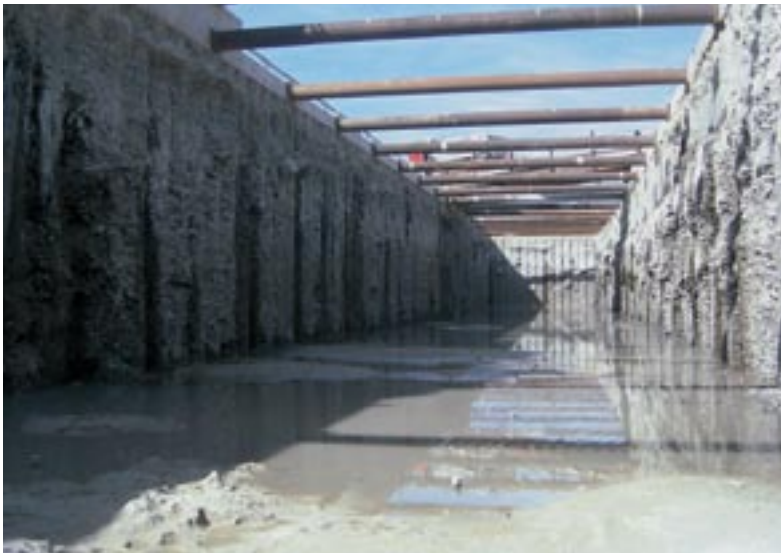
Bild 5: Gelenzte Baugrube, Oberkante Unterwasserbeton-Sohle
