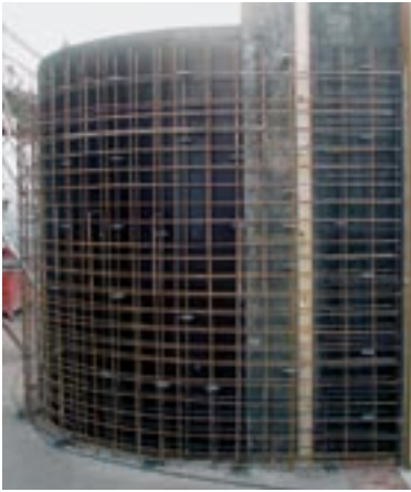
Bild 14: Gekrümmte Rampenwand zur Tiefgarage; links: Bewehrungsführung, rechts: Rampenwand nach dem Ausschalen
