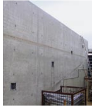
Bild 15: Der maßhaltige Einbau von Einbauelementen
