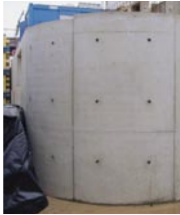
Bild 14: Gekrümmte Rampenwand zur Tiefgarage; links: Bewehrungsführung, rechts: Rampenwand nach dem Ausschalen
