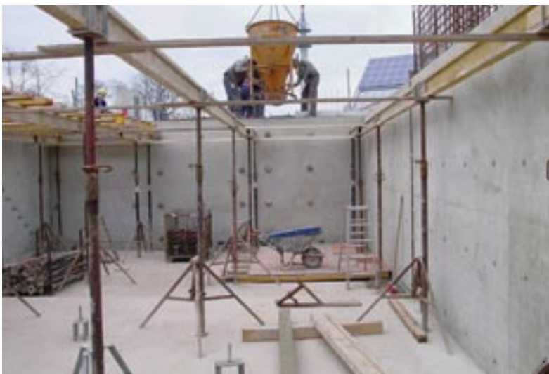
Bild 13: Basis für hochwertige Sichtbetonbauwerke: eine saubere Baustelle
