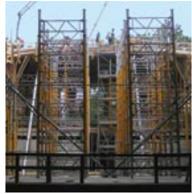
Bild 8: Betonieren des ersten Dachs
