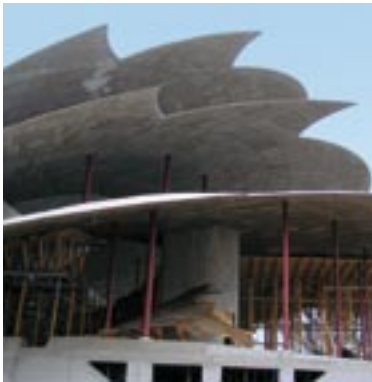
Bild 14: Rohbau im Dezember 2004
