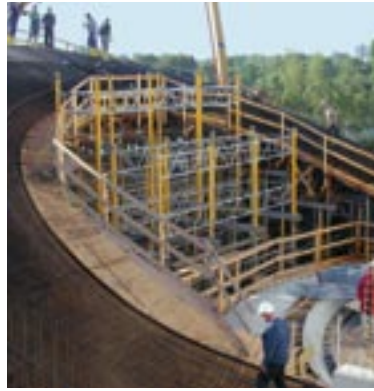
Bild 7: Einbau des Transportbetons mit einer Pumpe
