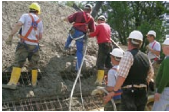
Bild 5: Einbau des Betons auf einer geneigten Probefläche
