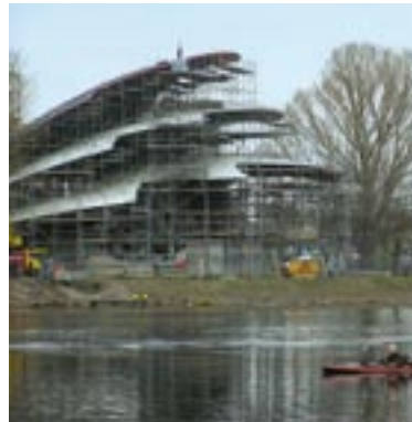
Bild 15: Baufortschritt im April 2005
