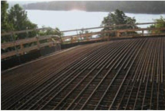
Bild 4: Bewehrungsanordnung auf dem Schrägdach
