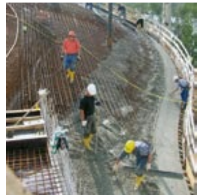
Bild 12: Manuelles Glätten der Dachoberfläche
