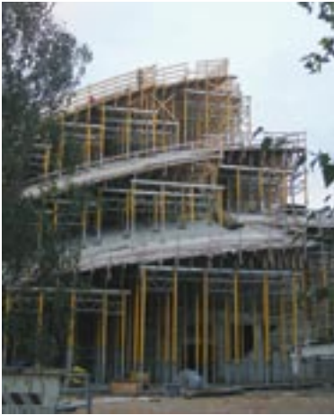
Bild 2: Seitlicher Blick auf die eingeschalteten Dächer
