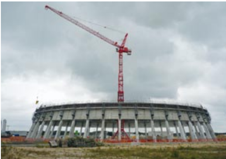
Bild 1: Neubau eines Naturzugkühlturms in Boxberg
