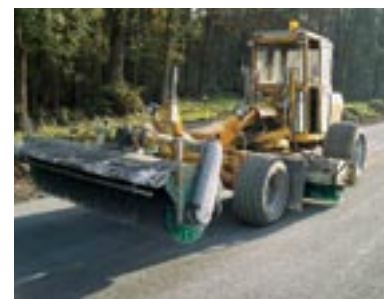
Bild 16: Ausbürsten des Oberflächenmörtels
