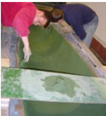
Bild 11: Aufspachteln der ersten Mörtellage
