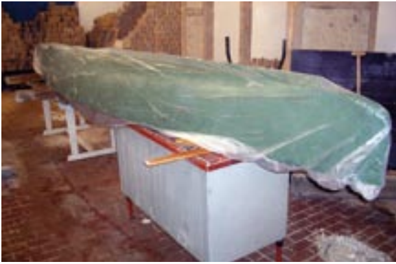
Bild 14: Nachbehandlung durch Bedecken mit Folie
