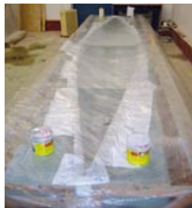
Bild 13: Nachbehandlung durch Belassen in der Schalung
