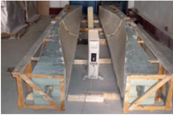
Bild 10: Die fertigen Schalungsteile
