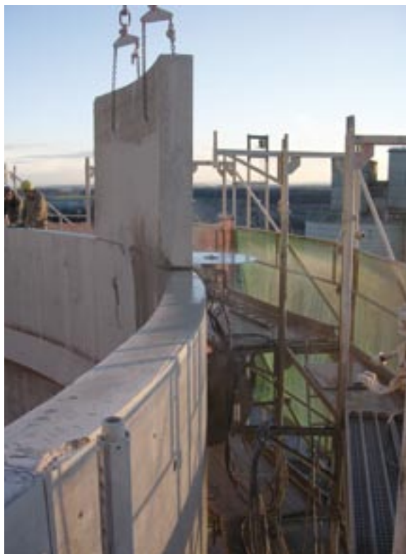
Bild 6: Horizontaler Schnitt in die Behälterwand ...
