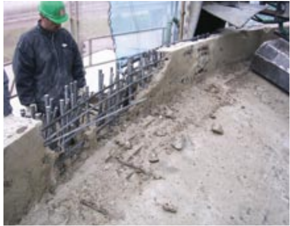
Bild 8: Freilegung der Anschlussbewehrung ...
