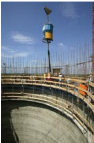
Bild 15: Einbau des Betons mit Kübel ... Bild 16: ... und Schlauch ...
