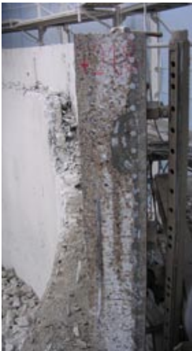
Bild 1: Instandsetzungsarbeiten 1996 an Silo 7: Innenzylinder und Spritzbetonauftrag außen (dunkel gefärbt)
