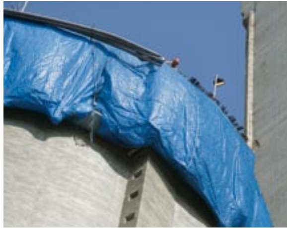
Bild 12: Die Lisenen gleiten mit.
