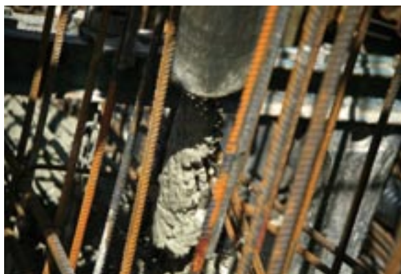
Bild 17: ... in die Schalung
