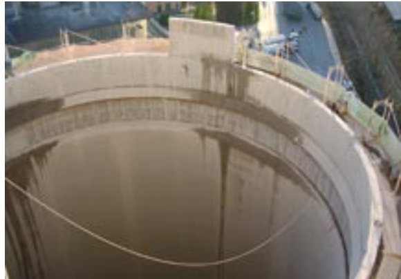
Bild 2: Absacken des Innenzylinders 2002 um 2 m ...
