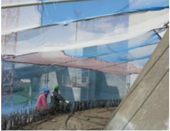
Bild 10: ... mit entsprechender Einhausung.
