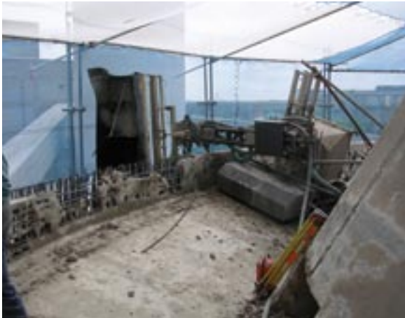
Bild 9: ... durch Abtrag des Betons mit Hochdruckwasserstrahl ...
