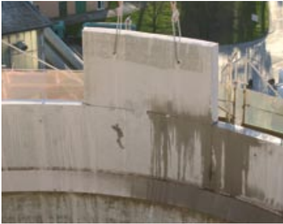
Bild 7: ...und Abbau mit einem Kran.
