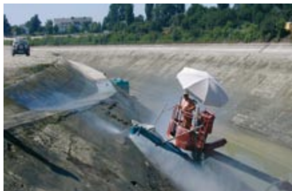
Bild 11: Reinigung der Böschung mit Hochdruckwasserstrahl
