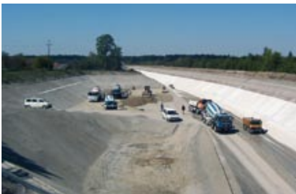
Bild 10: Neubau der Bootseinsatzstelle
