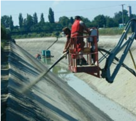
Bild 12: Vorbereitung der Böschung durch Fehlstellenausbesserung mit Nassspritzbeton
