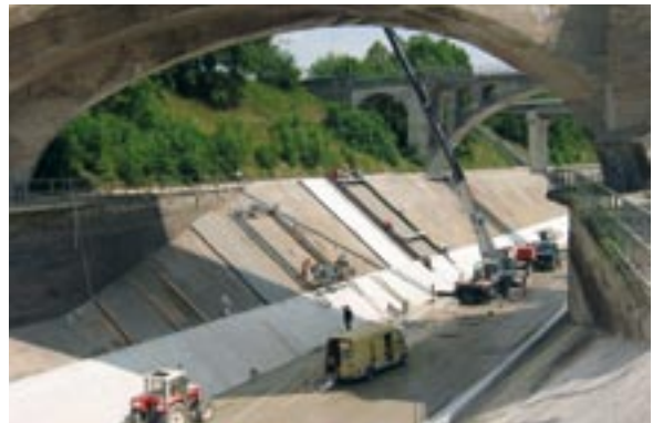
Bild 23: Einbau des Böschungsbetons mit Handeinbaufertiger, Feldbreite 3 m
