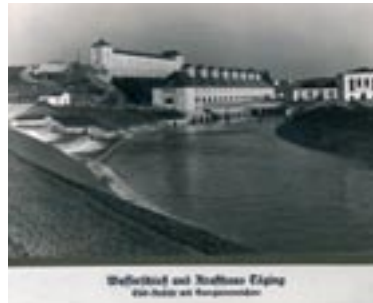
Bild 2: Wasserschloss und Krafthaus Töging
