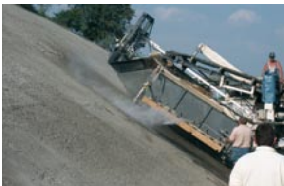
Bild 16: Vornässen des Böschungs-Altbetons
