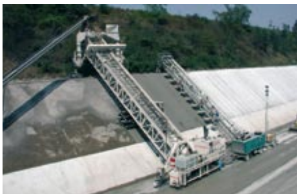
Bild 18: Betonieren mit einem FCX-Böschungsfertiger
