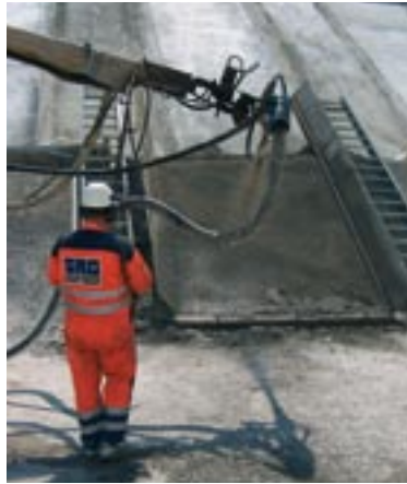
Bild 25: Einbau des Böschungsbetons als Spritzbeton
