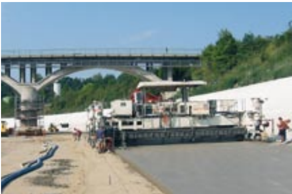
Bild 27: Einbau des Sohlebetons mit einem üblichen Straßenfertiger mit 10 m Arbeitsbreite
