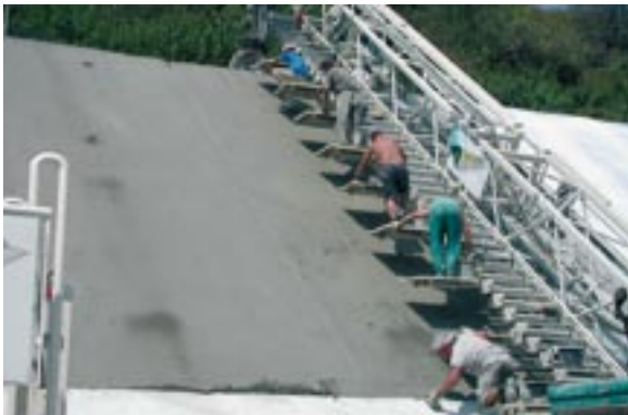
Bild 21: Glätten der Betonflächen nach Einbau mit dem FCX-Fertiger
