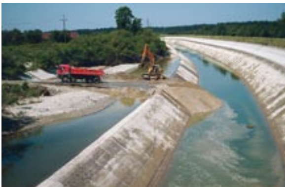
Bild 14: Aufschüttung von Zufahrtsrampen
