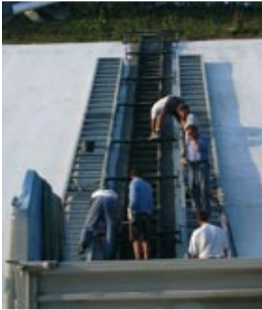
Bild 22: Händischer Einbau von Beton bei den Böschungstrepfen
