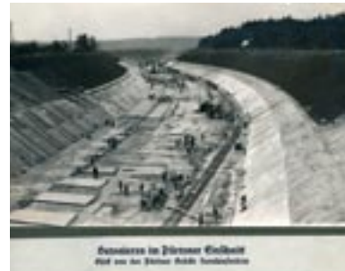
Bild 3: Betonierarbeiten im Kanal 1920
