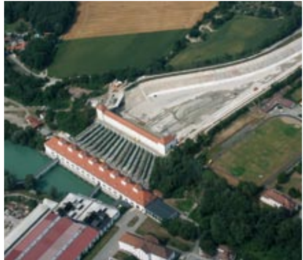
Bild 8: Wasserschloss und Krafthaus
