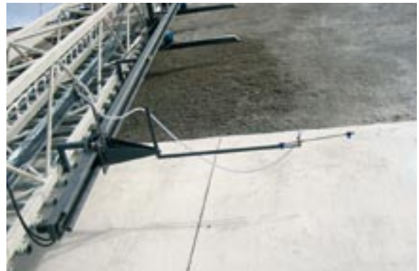
Bild 29: Aufsprühen des weiß pigmentierten Nachbehandlungsmittels über Nachläufer an den FCX-Fertigern
