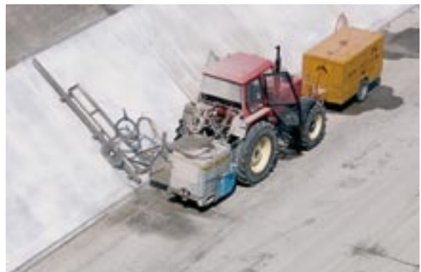
Bild 26: Schneiden der Scheinfugen an der Kanalböschung im Abstand von 5 m
