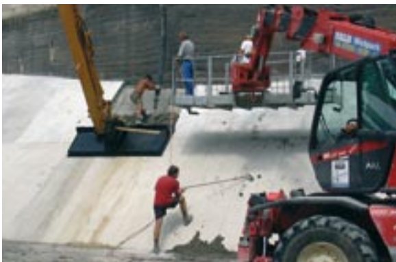
Bild 24: Einbau des Böschungsbetons mit Bagger und Rüttelbohle, Feldbreite 3 m
