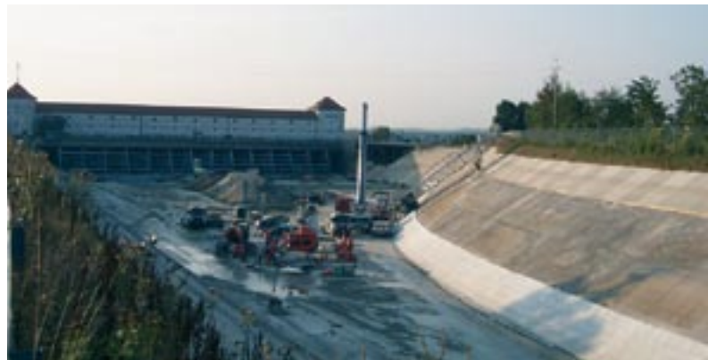
Bild 5: Erneuerung der Sohlen im Einlaufbereich
