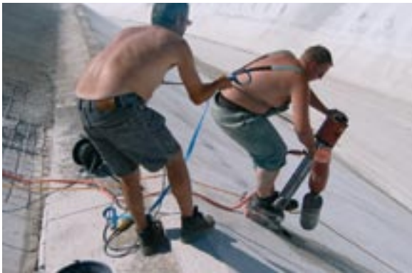
Bild 32: Entnahme von Bohrkernen aus dem Böschungsbeton
