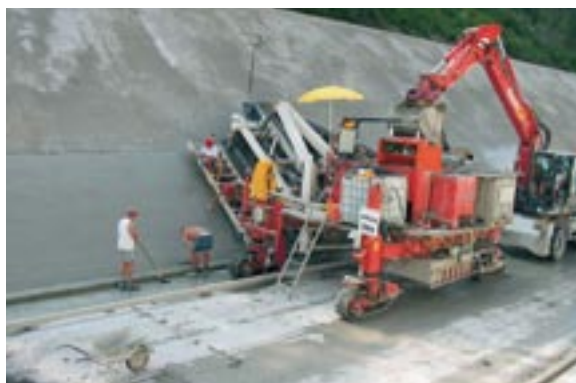
Bild 17: Einbau von Böschungsbeton mit angeformtem Fuß auf der Kanalsohle
